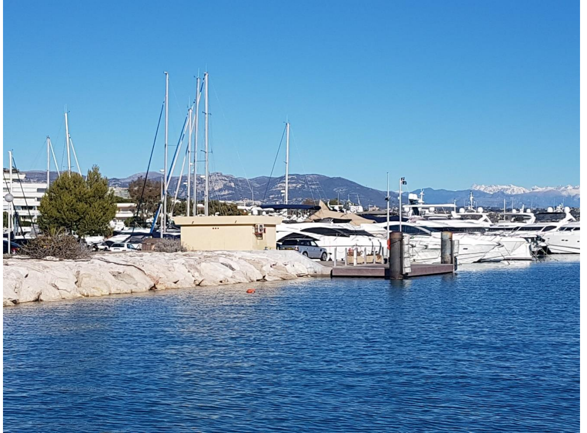
Photo 4 : Ponton d'accueil actuel
