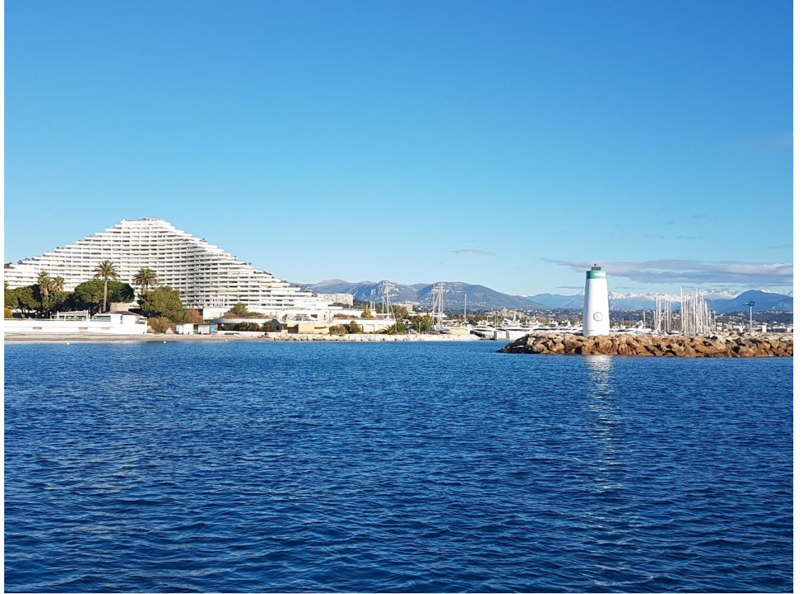
Photo 1 : Musoir existant vue de l'extérieur du port
