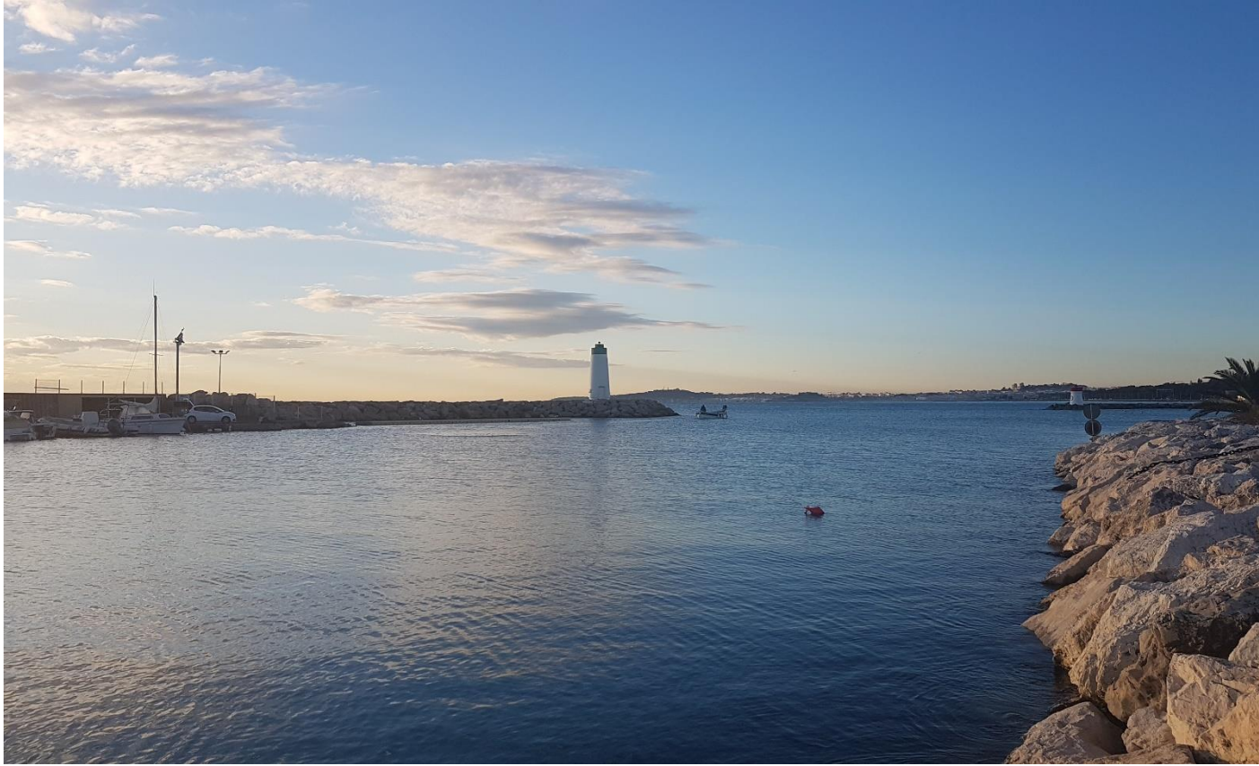
Photo 2 : Musoir existant vue de l'intérieur du port
