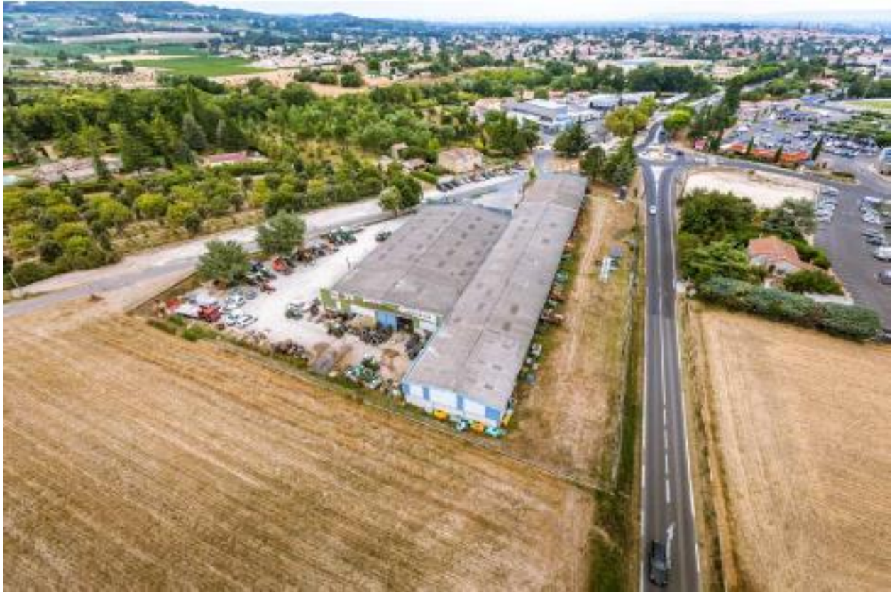
Illustration 9 : Vue sur la zone du projet – direction sud-ouest (source : Arck'In'Tech)
