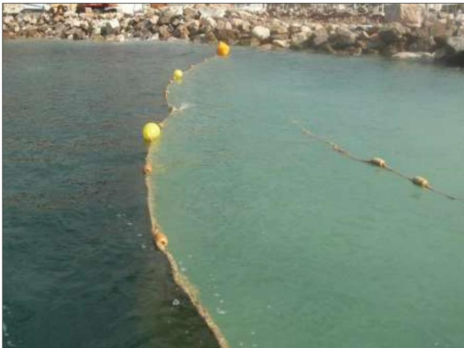
Figure 5-2 : illustration de l'efficacité d'une membrane de confinement.
