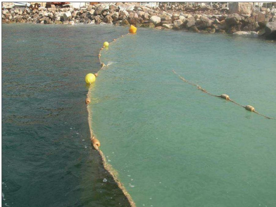
Figure 87 : illustration de l'efficacité d'une membrane de confinement.
