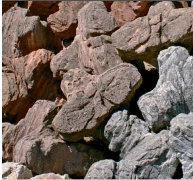
**Figure 5: illustration des blocs béton Ecopode™ – exemple de texture et coloration (blocs visibles dans la zone hors d'eau dans le cadre du projet)**
