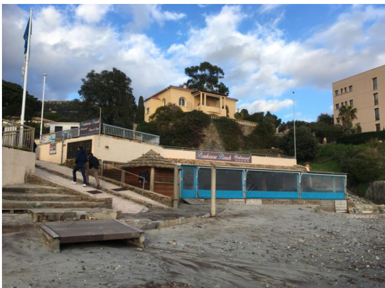
Illustration 22 : Accès sur la Plage du Rayol Ouest depuis le parking (source : Cereg)
