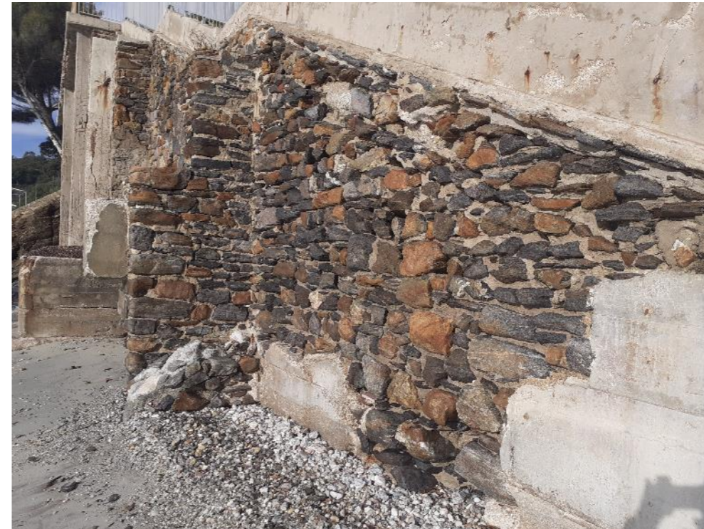
Etat de l'appareillage de façade existant
