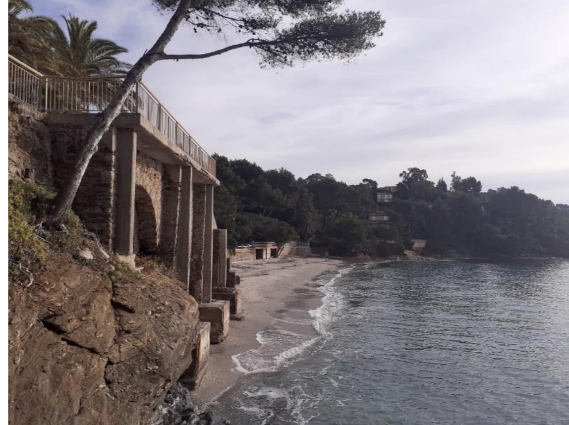
Vue depuis le poste de surveillance à l'Ouest
