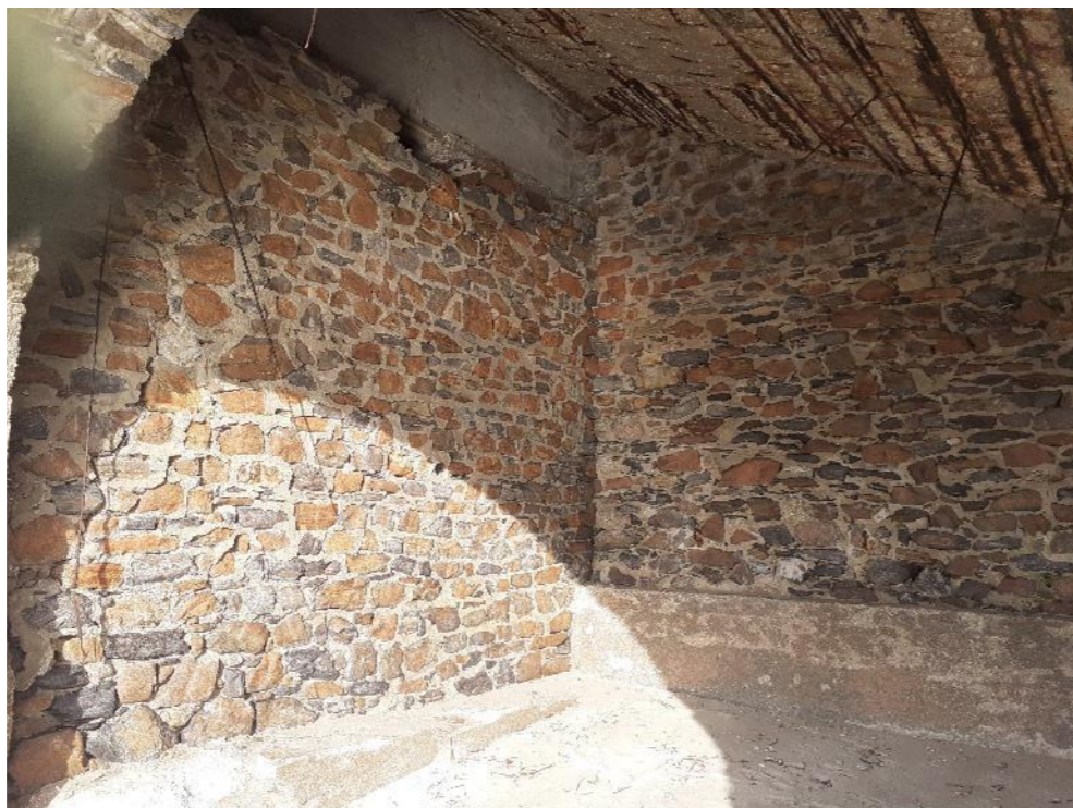
Appareillage sous route 1
