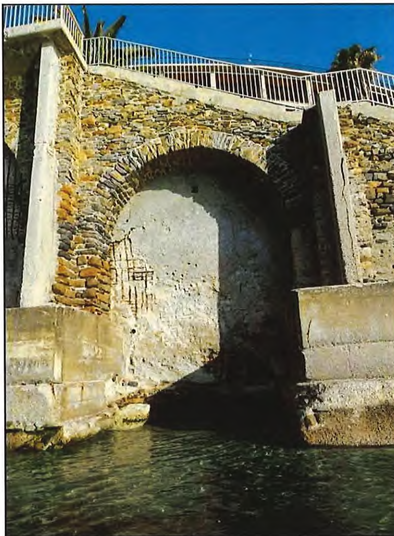
Figure 27 : Vue de la travée T3.
