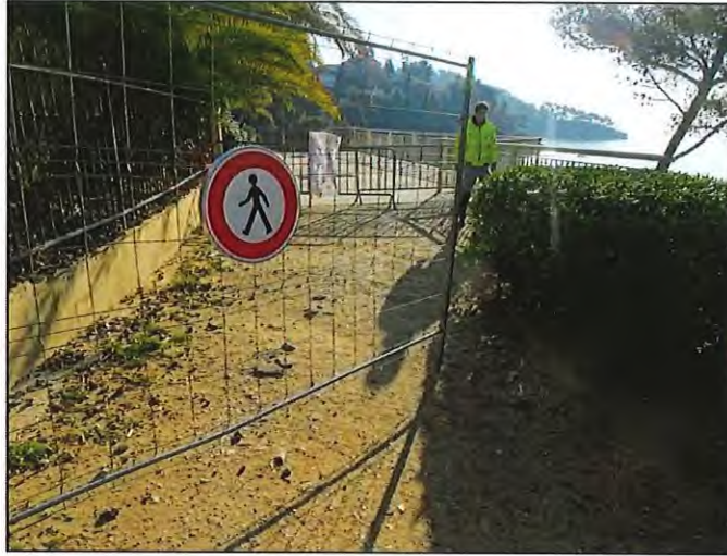
Figure 18 : Vue depuis l'accès à l'ouvrage à l'Ouest.
