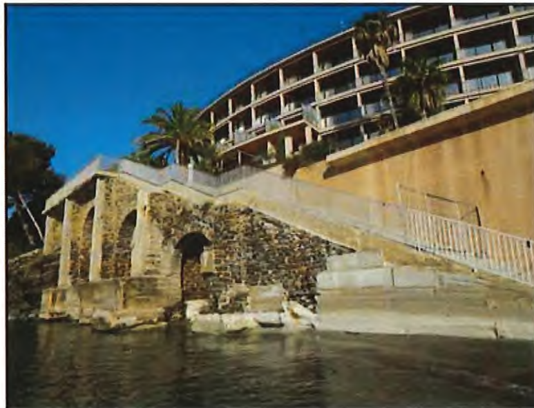
Figure 1 : Escalier public d'accès à la plage du Rayol Est.
