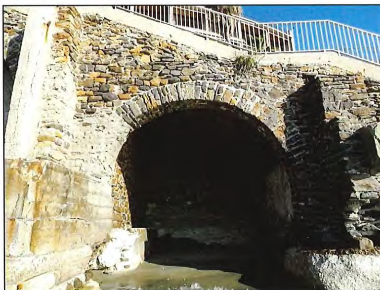
Figure 28 : Vue de la travée T4.
