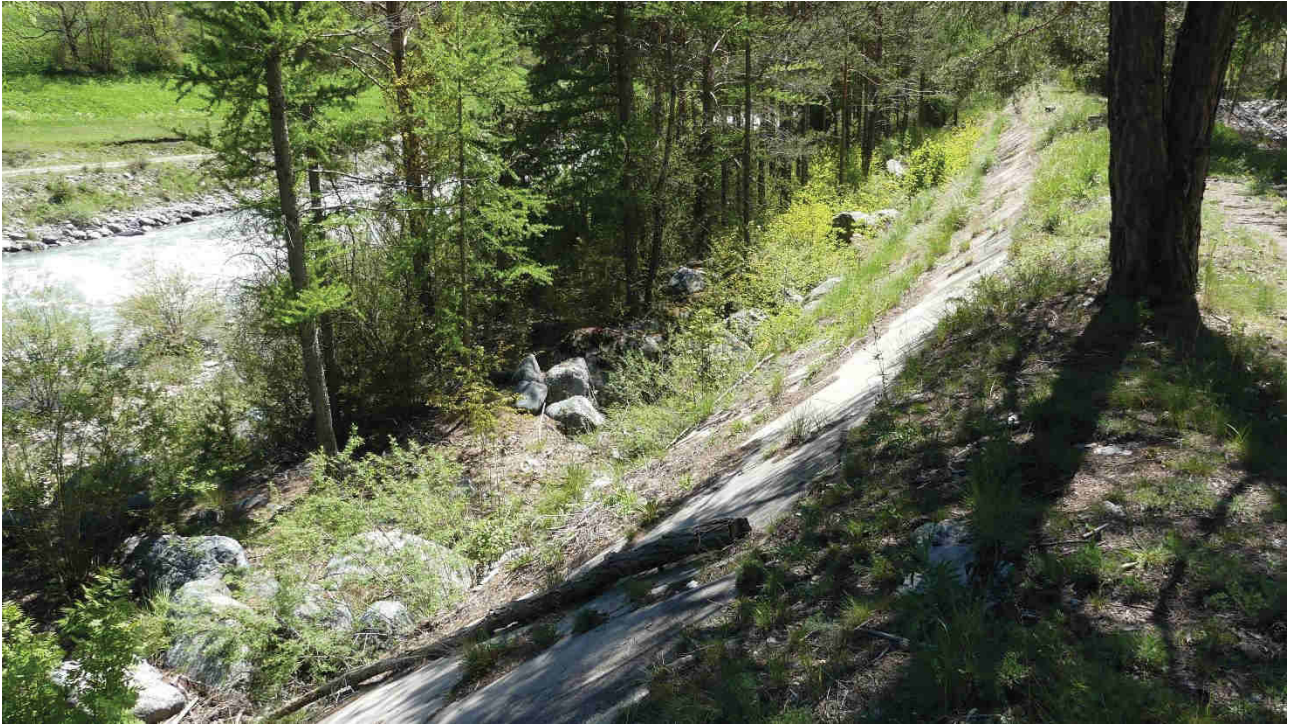
Photo 3 : Digue des Planissaux (qui sera démontée)
