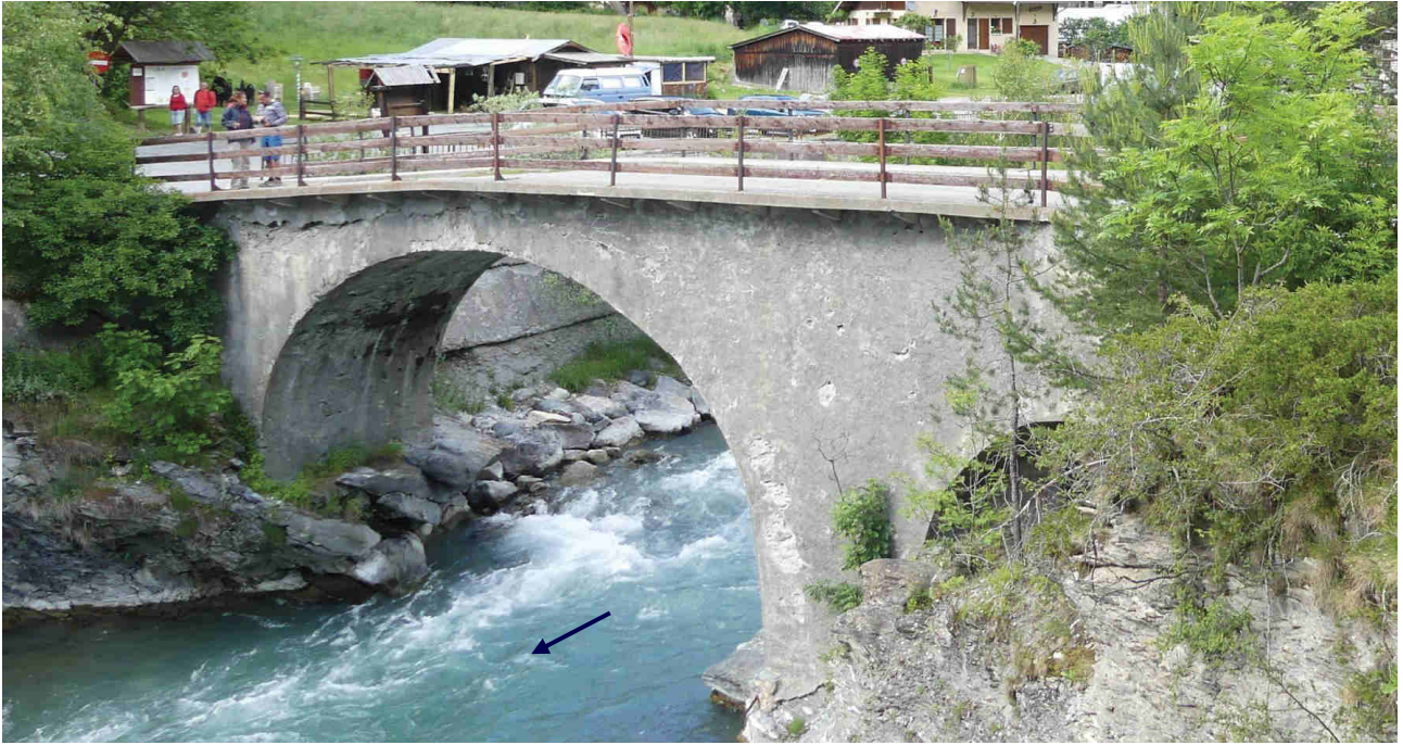
Photo 11 : Le pont de Pasquet vu de l'aval
