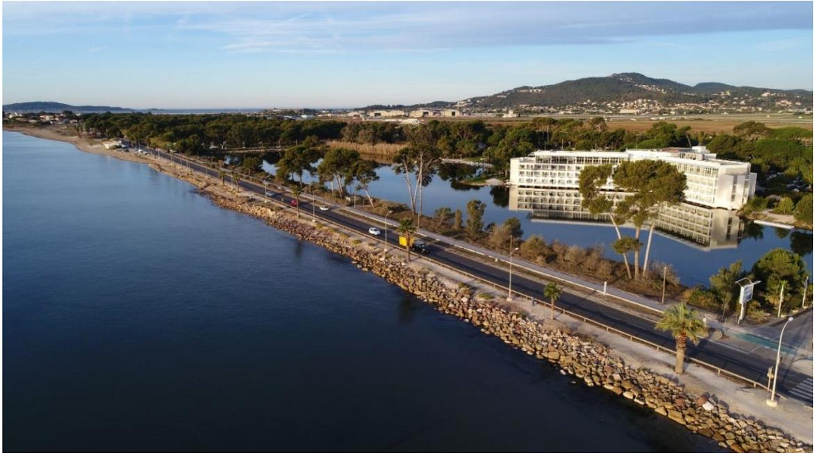
Figure 66 : Vue aérienne du boulevard de la Marine avec sa protection de talus en enrochements - 2008
