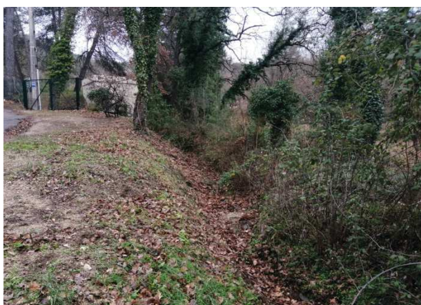
Photo 8 : Fossé pluvial- partie amont
