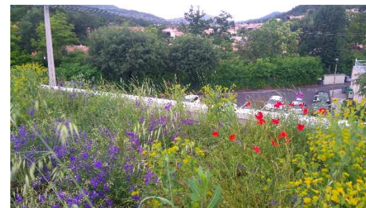
Toiture plantée lycée Pierre Gilles de Gennes (Digne les bains)
