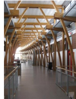
Accès technique pour l'entretien des vitrages
