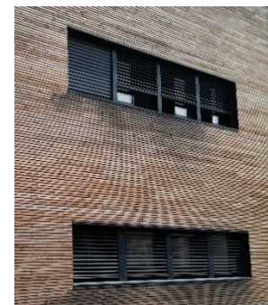
Brise-soleil orientables et relevables – Lycée Langevin – La Seyne sur mer
