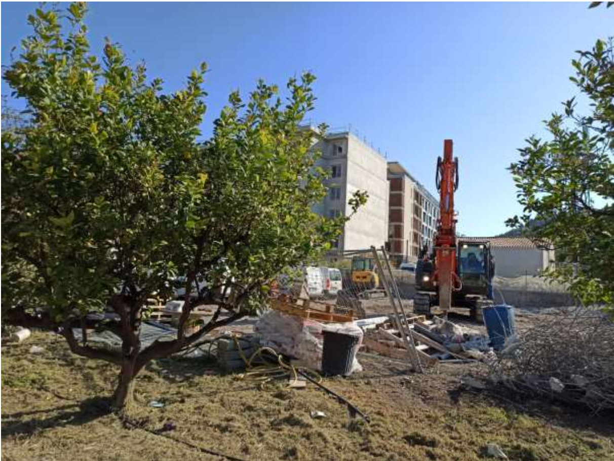
Photo 7 : Vue n°3, sur le chantier en cours situé à l'est du secteur d'étude (Even, Mars 2021)
