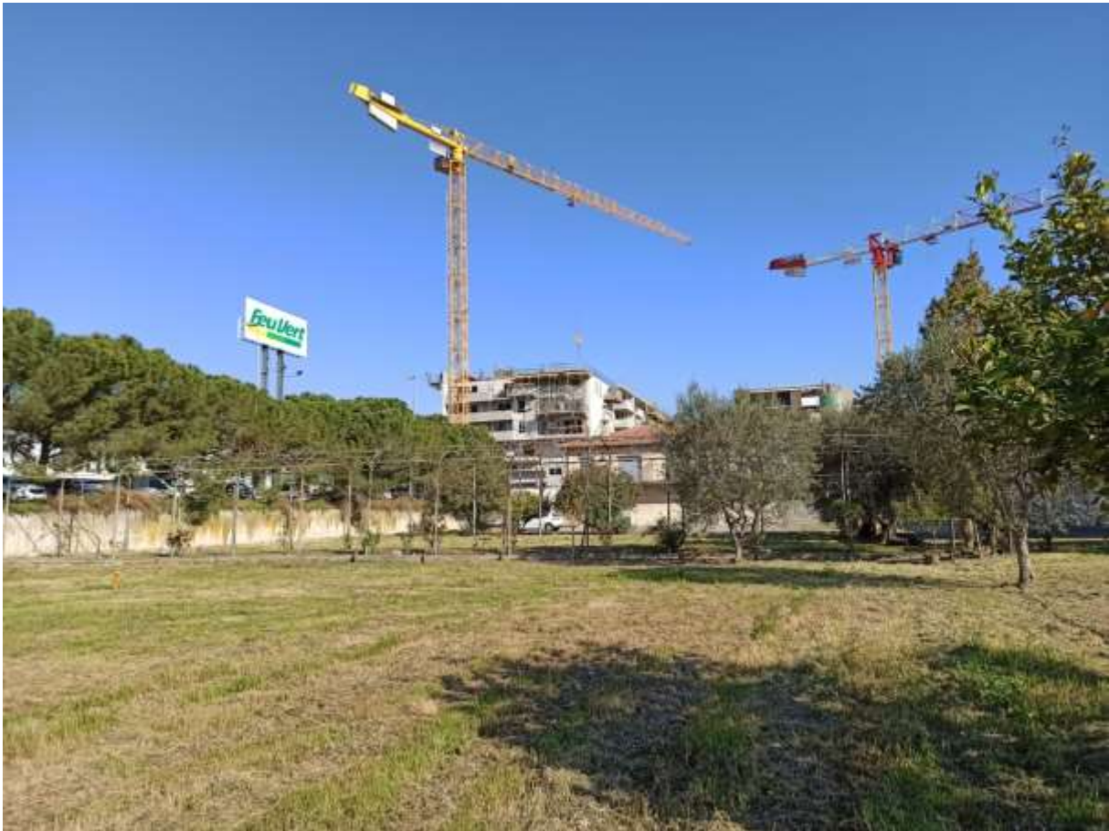
Figure 29 : Chantier à proximité du secteur d'étude (Google earth)
