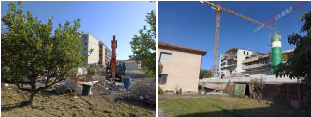
Photo 3 : Chantier à l'est et au nord du secteur d'étude (EVEN, Mars 2021)
