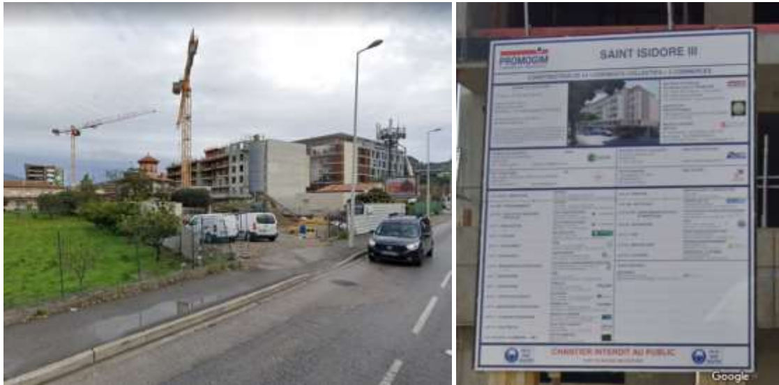
Figure 26 : Chantier en cours à l'est du secteur d'étude (Google street view)
