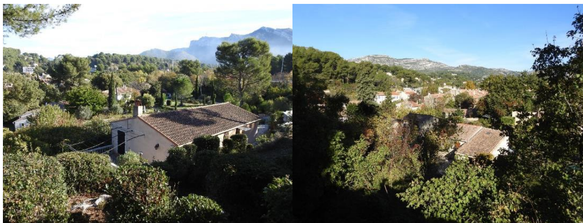
Figure 34 : Bâtiments présents sur le site d'étude (Source : B. VOLLOT pour Ecotonia)
