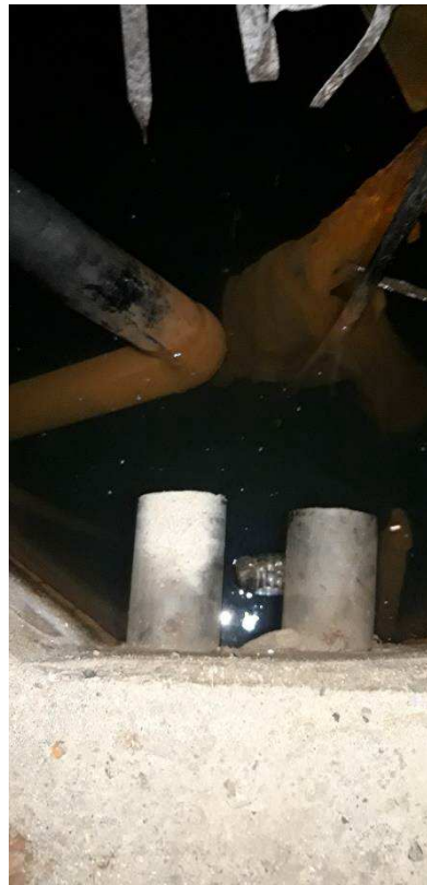
Figure 6 : deux PEHD diam. 150 mm repéré dans le local technique (figures 1 et 2)
