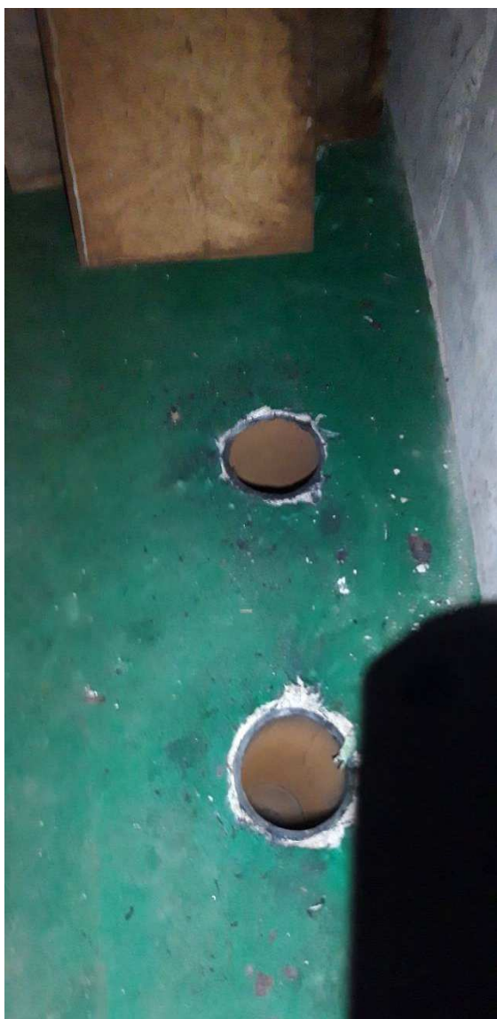
Figure 1 : Local technique, 2 PEHD Diam. 150 mm se dirigeant vers le terre-plein
