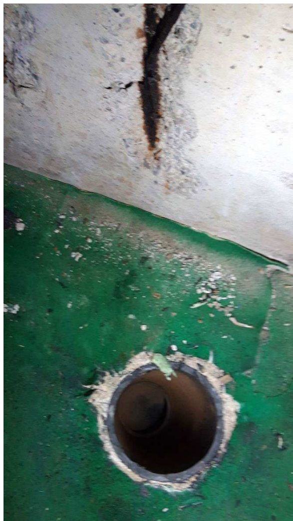
Figure 2 : zoom sur un PEHD diam. 150 mm
