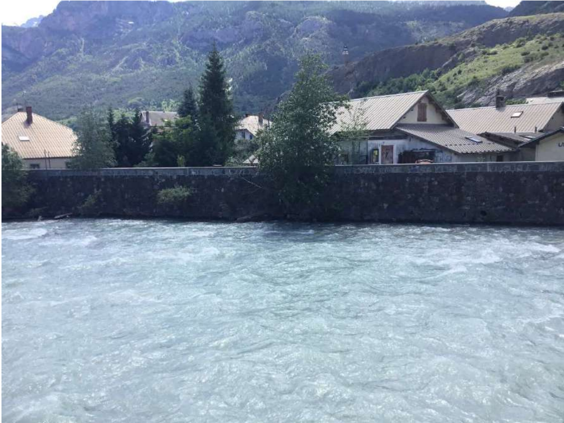
Photo 1 : Digue Rive Droite Aval, Vue depuis le parking de l'ancienne trésorerie de l'Argentière-La Bessée 28 mai 2020
