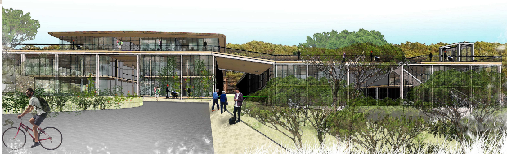
Vue des bureaux
