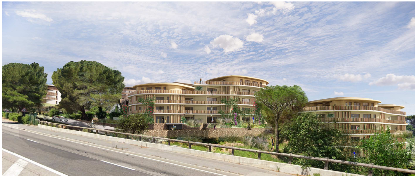
Vue des logements
