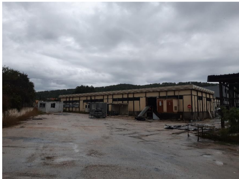
Photographie 11 : Bâtiment abandonné et container bloquant un accès du site
