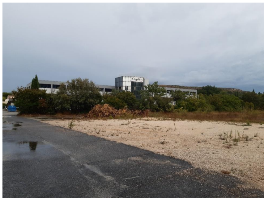
Photographie 17 : Vue depuis le sud-ouest sur l'espace non imperméabilisé et le bâtiment en cours de rénovation
