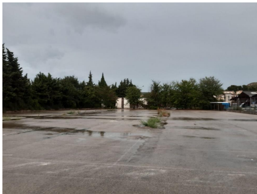
Photographie 14 : Ancienne zone de stockage
