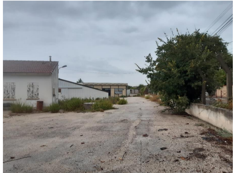
Photographie 8 : Limite nord du site avec le chemin des Pinchinades à droite
