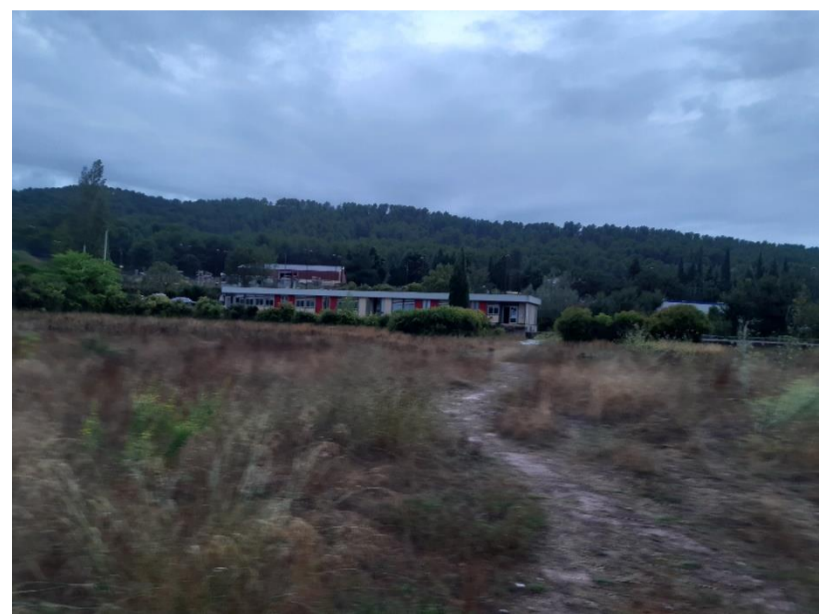
Photographie 10 : Espace non imperméabilisé et bâtiment sud
