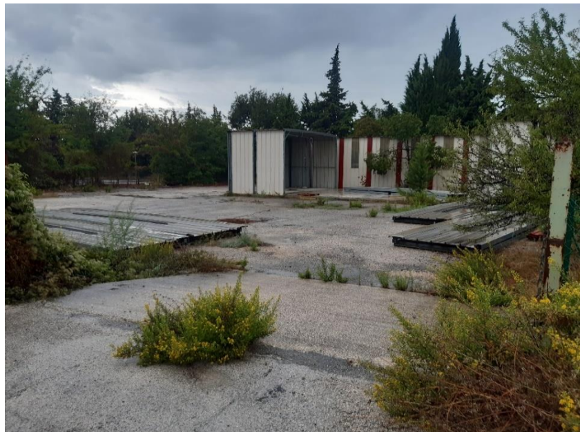
Photographie 13 : Rampe accès bâtiment abandonné
