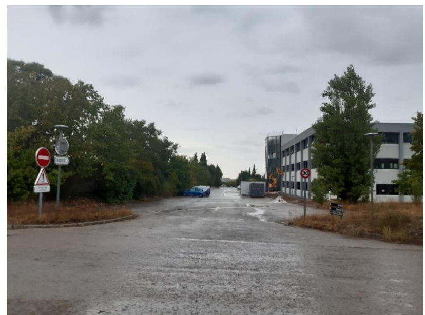
Photographie 6 : Rue au sud du bâtiment en cours de rénovation
