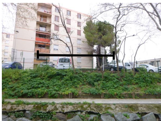
Aperçu du positionnement de la passerelle en rive gauche
