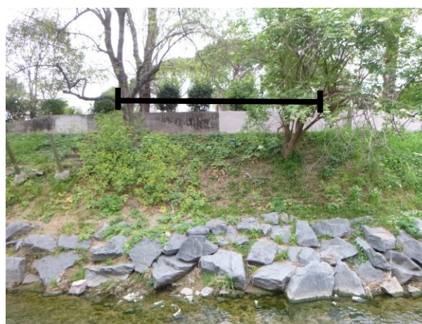
Aperçu du positionnement de la passerelle en rive droite
