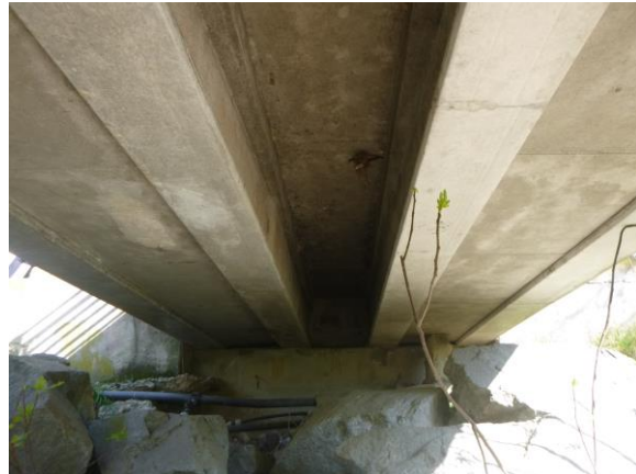
Aperçu de la passerelle zone 5, non favorable aux gîtes de chiroptères
