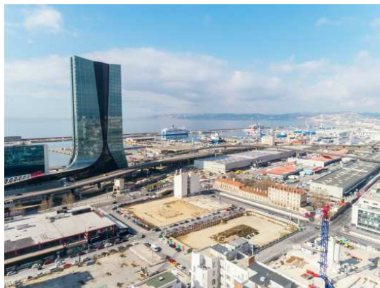
PC8.1 - Vue depuis le Sud-Est
