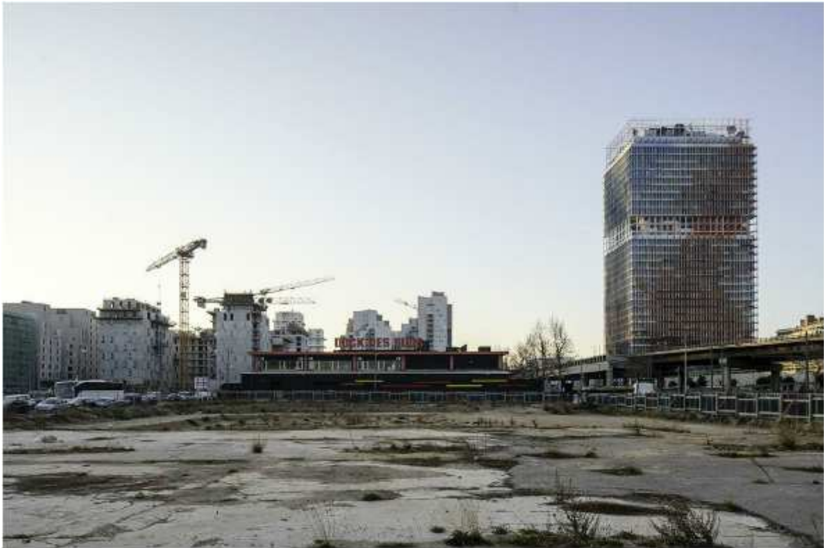
PC7.1 - Vue depuis l'ilot 1C
