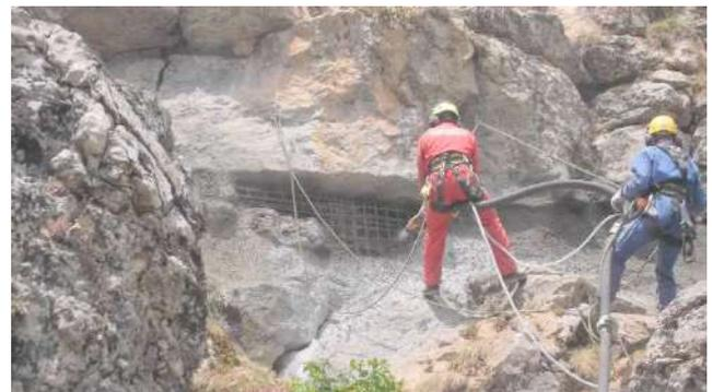
fig. 34 : vue de la technique de béton projeté pour réaliser un buton (protection contre les chutes de blocs)
