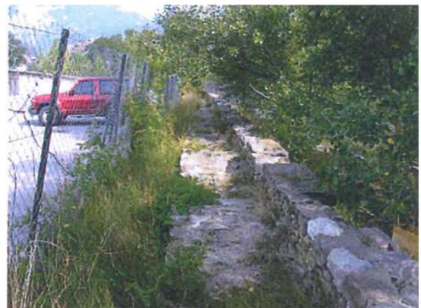
fig. 6 : vue des voûtes du mur-digue (largeur 1,10 m) et du mur en maçonnerie qui dépasse de 0,50 m, dans le secteur de la Chapelle –Gendarmerie (photo SOGREAH)
