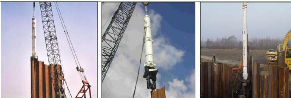
fig. 42 : exemple d'engin de battage par pelle à câble équipée avec un marteau
