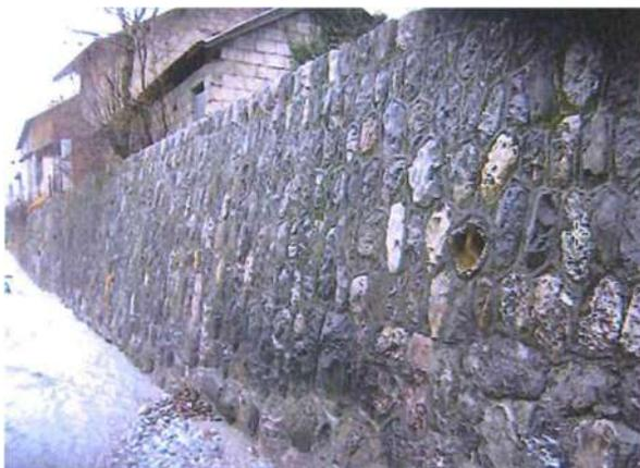
fig. 5 : amont du pont de la Bessée : mur digue en maçonnerie à l'origine (photo SOGREAH)
