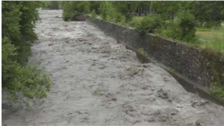
fig. 28 : vue d'une accélération des écoulements le long d'une digue verticale et lisse
