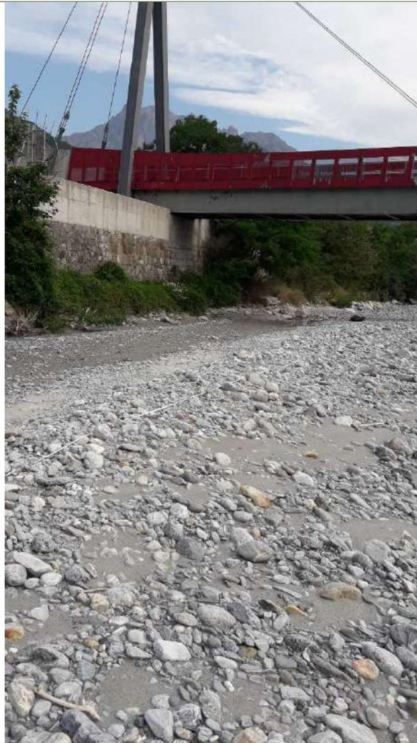
fig. 23 : site aval : 3ème relevé granulométrique
