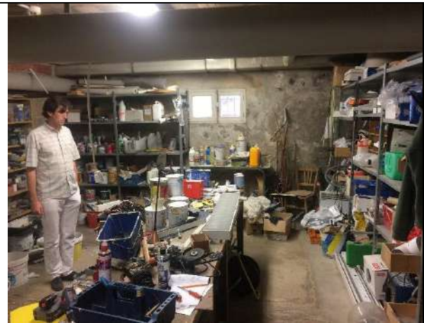
Atelier attenant à la chaufferie sous la chapelle
