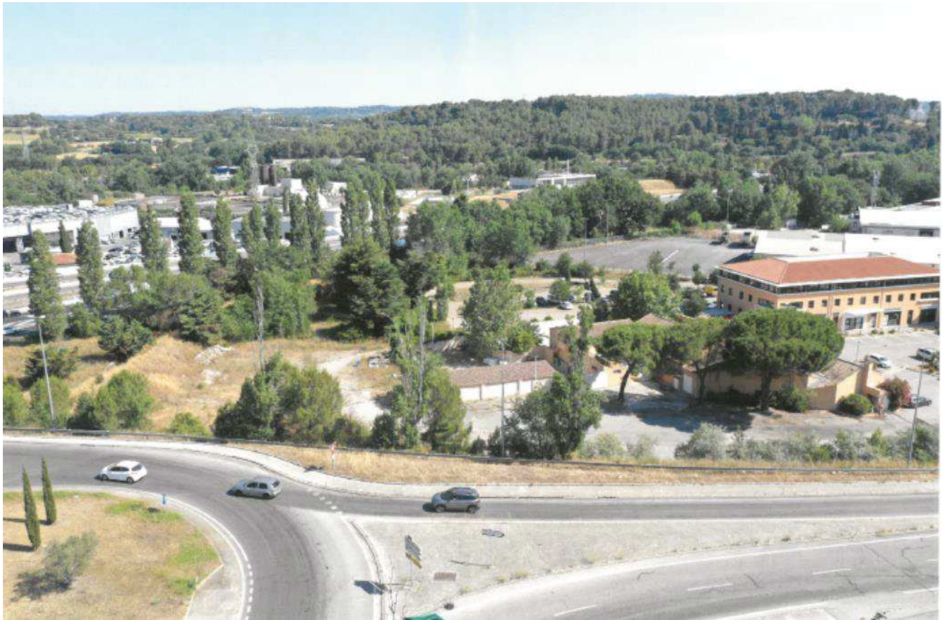
Vue depuis le Sud de la parcelle
