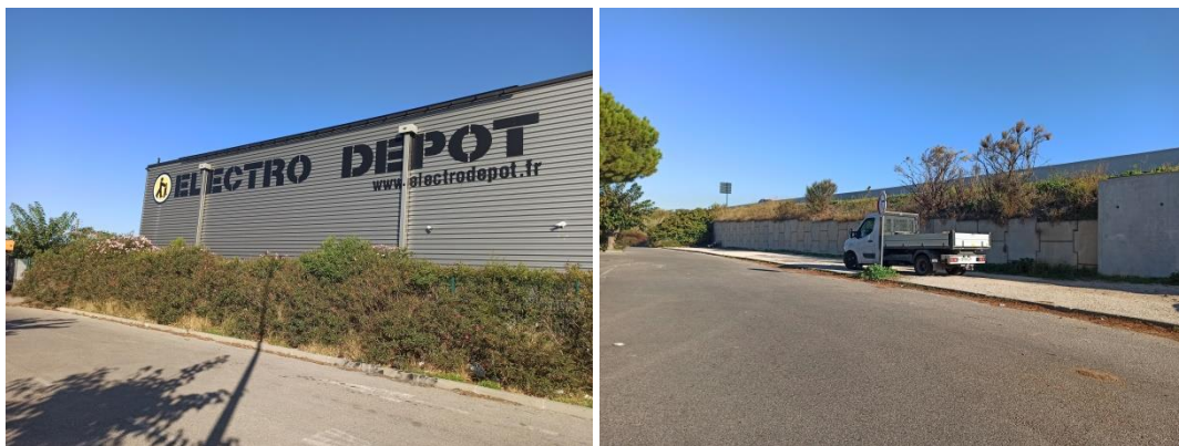
Photo 3 et 4 : Clôture végétalisée située au nord du secteur d'étude et mur en pierre en contrebas de la RD26. (EVEN, Octobre 2020)
