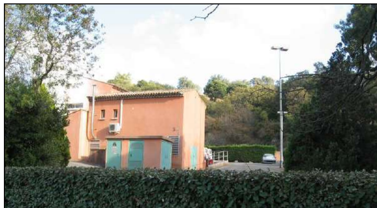
Aperçu de la végétation autour de la STEP actuelle
