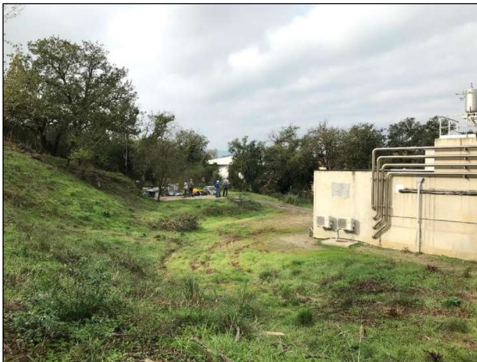
Figure 14 : Prise de vue 9 de la zone de projet envisagée au Sud (Source : EKOS Ingénierie)
