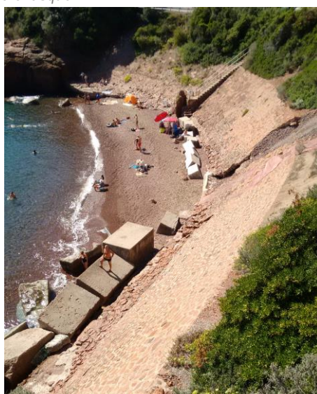
Perrés, blocs de béton et plage de galets mobiles
