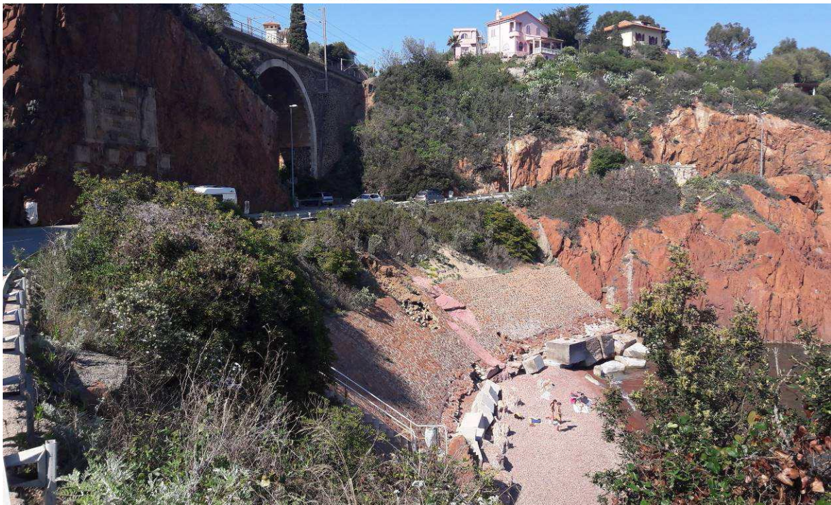
Figure 1 : Localisation du perré et vue lointaine de celui-ci (Source : Département du Var)
