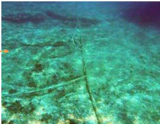
Une gaine plastique contenant un fil de cuivre de diamètre 0,5 à 1 cm est enroulée autour du câble DIDON. Il semblerait s'agir d'une autre portion de câble qui a perdu totalement son enveloppe protectrice. Le tout est posé sur de la roche à 4 mètres de profondeur.
