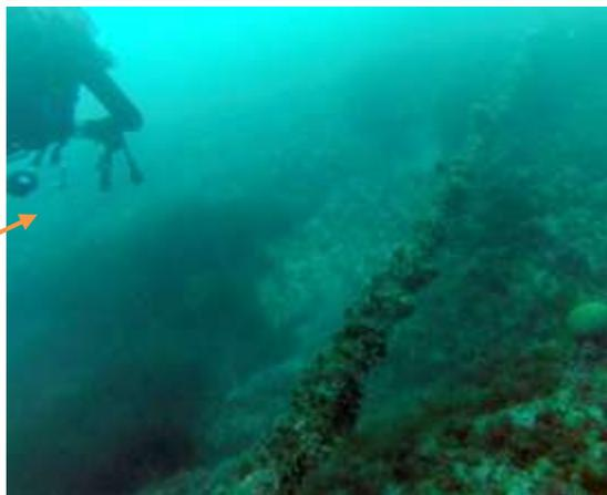
Sur 40 mètres linéaires à l'intérieur de la zone marine protégée du Cap Couronne, le relief sous-marin présente des cassures sous forme de marches de 1 à 3 mètres de hauteur, formant des petits tombants. Le câble AMITIE est suspendu dans l'eau à 50 cm au-dessus du fond et n'entre en contact que sur quelques points d'appuis. Il est très facile de le faire bouger à la main.
