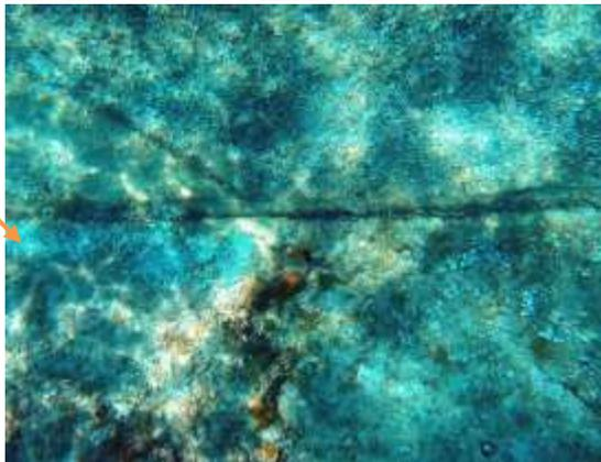
Une chaîne d'une trentaine de mètres est emmêlée autour du câble DIDON. Il s'agit probablement du mouillage d'un bateau qui s'est enrégé sur le câble.
