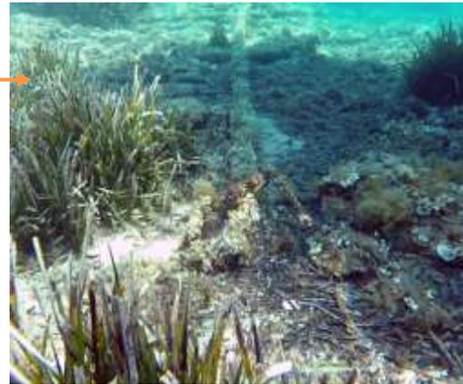
Du côté Est de l'anse, le câble DIDON démarre à la limite de la zone de baignade à 2,50 mètres de profondeur. Il est posé sur un fond rocheux composé d'herbier de Posidonie à faible recouvrement. On peut observer un phénomène de dégradation des habitats aux abords du câble provenant d'un mouvement latéral de celui-ci lorsque la mer est agitée.
