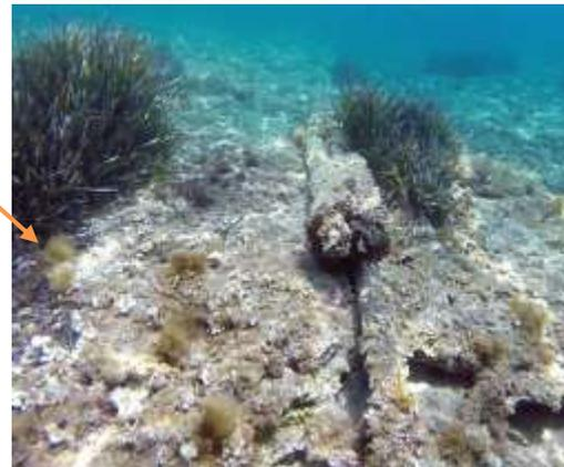
5 mètres plus loin, les parties n°3 des câbles BARMAR et FRANCE ALGERIE 4 démarrent et sont collés au câble DIDON. Ces 3 câbles sont toujours posés sur un fond rocheux composé d'herbier de Posidonie à faible recouvrement.
