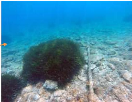
Le câble AMITIE bifurque vers l'Ouest de la calanque. Il est posé sur de la roche à 4 mètres de profondeur et passe à proximité d'une tâche d'herbier de Posidonie dans la zone de baignade.
