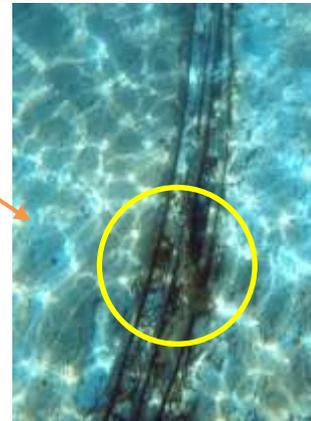
4 câbles (AMITIE ; BARMAR partie n°2 et n°3 ; FRANCE ALGERIE 4 partie n°2) sont regroupés sur un fonds sableux à 5 mètres de profondeur. Un des câbles est sectionné et en train de se détacher (cercle jaune sur la photo). Le câble AMITIE, le plus à l'Ouest, bifurque ensuite pour se retrouver seul (cf. séries de photos page 11 et 14).
