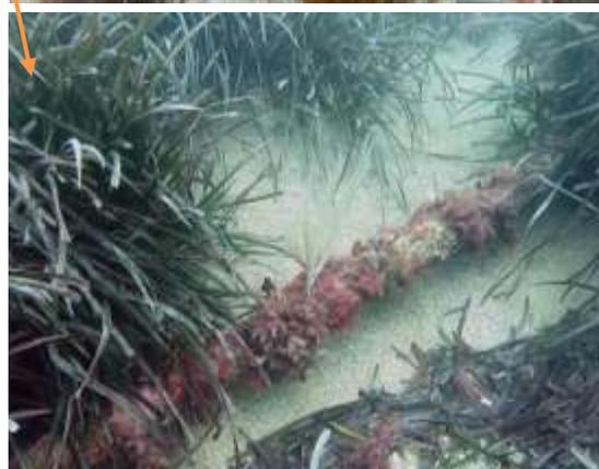
A partir de ce point à 16,5 mètres de profondeur, le câble FRANCE ALGERIE 4 est recouvert par de l'herbière de Posidonie sur plusieurs mètres. **Un repère de coupe a été posé sur du sable.**
