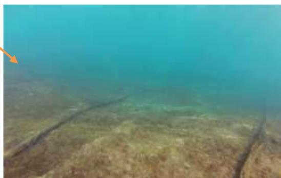
Les câbles BARMAR et FRANCE ALGERIE 4 ont leur enveloppe fortement endommagée et sont posés sur de la roche. Au vu de leur poids très léger et de la faible profondeur, inférieure à 4 mètres, ils sont fortement sujets aux déplacements et aux mouvements générés par la houle. Ce phénomène contribue à leur dégradation accélérée et à la génération de particules de plastique et de morceaux de métal (acier, cuivre) qui se disséminent et se fragmente dans le milieu marin.
