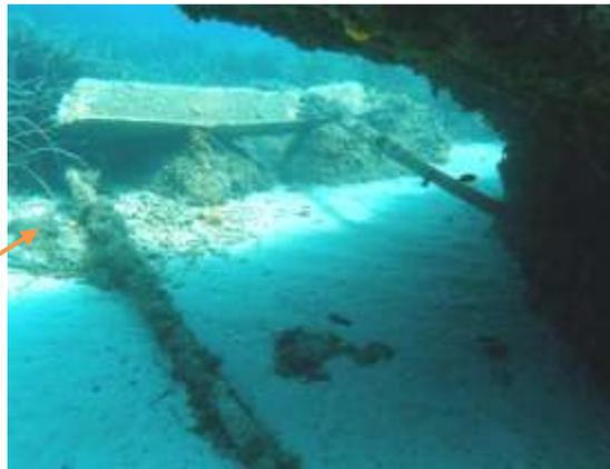
Une cornière en fibre de verre est présente sous le câble BARMAR, sans que l'on sache si c'est pour le protéger des têtes de roche en dessous ou si cette plaque est venue s'enrager sous le câble. Le câble BARMAR passe sous un surplomb rocheux de 2 mètres de large.
