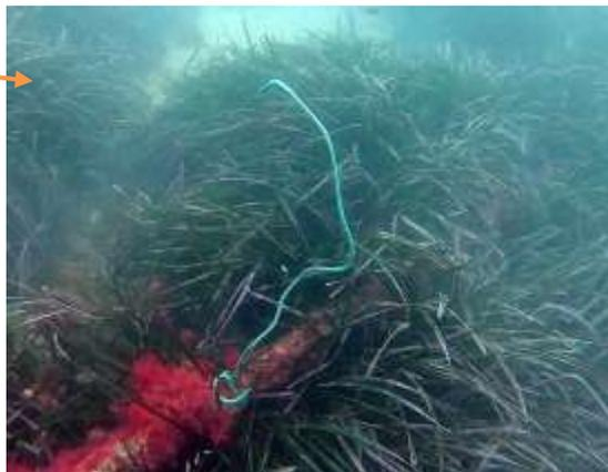
A partir de ce point à 17,1 mètres de profondeur, le relief sous-marin redevient en pente douce et sableux. Il est justifié de couper le câble AMITIE à cet endroit pour plusieurs raisons : il repose désormais sur le fond et n'est plus mobile ; la sédimentation est plus importante et il est probable que le câble commence à s'enfouir sur certaines portions ; la présence de Coralligène un peu plus loin a concrétionné autour du câble et l'emprisonne. **Un repère de coupe a été posé sur du sable.**
