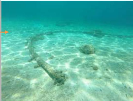
L'extrémité du câble AMITIE est posée sur un fond sableux de 3 mètres de profondeur à proximité immédiate de la zone de baignade. Il est libre et non ancré.
