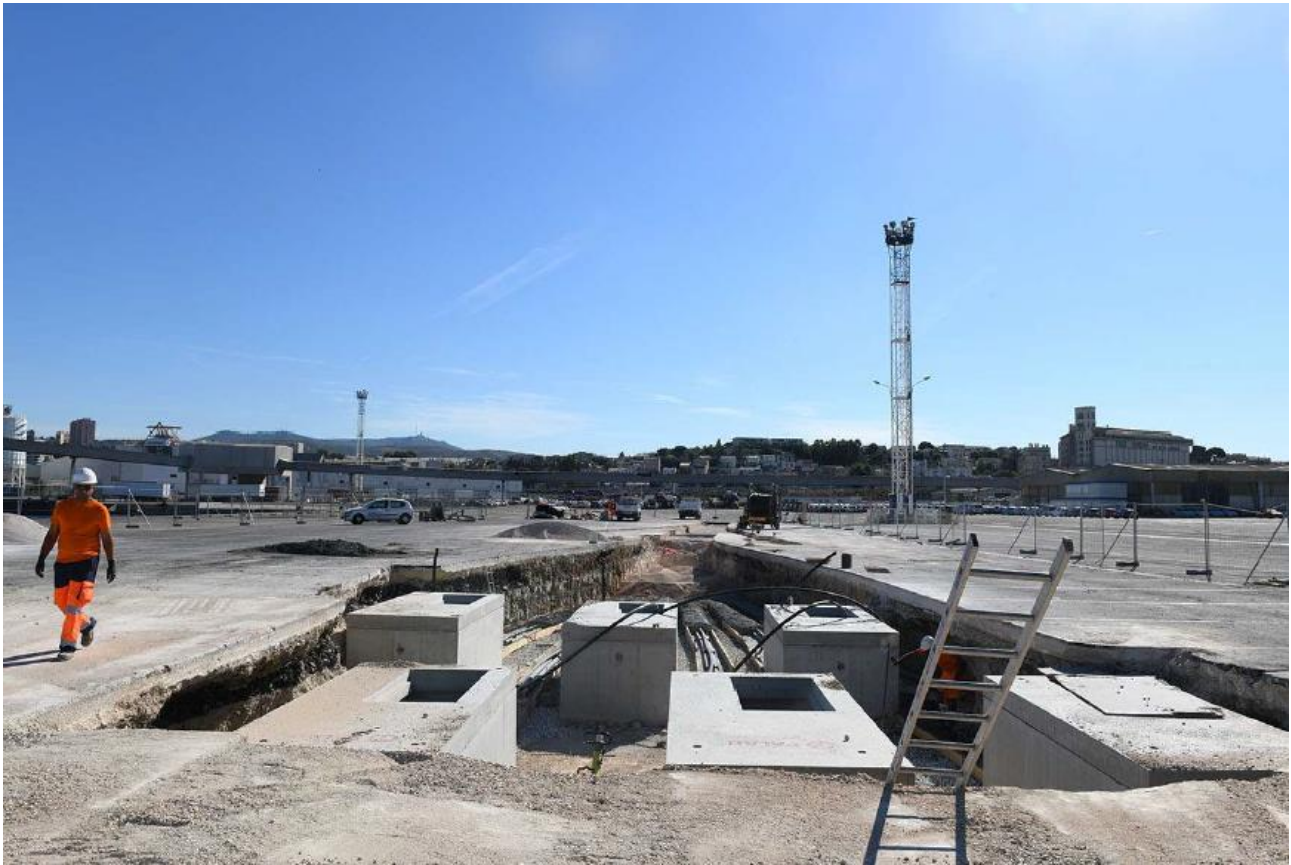
Figure 7 : Chambres d'atterrage lors de leur construction (source : GPMM)
