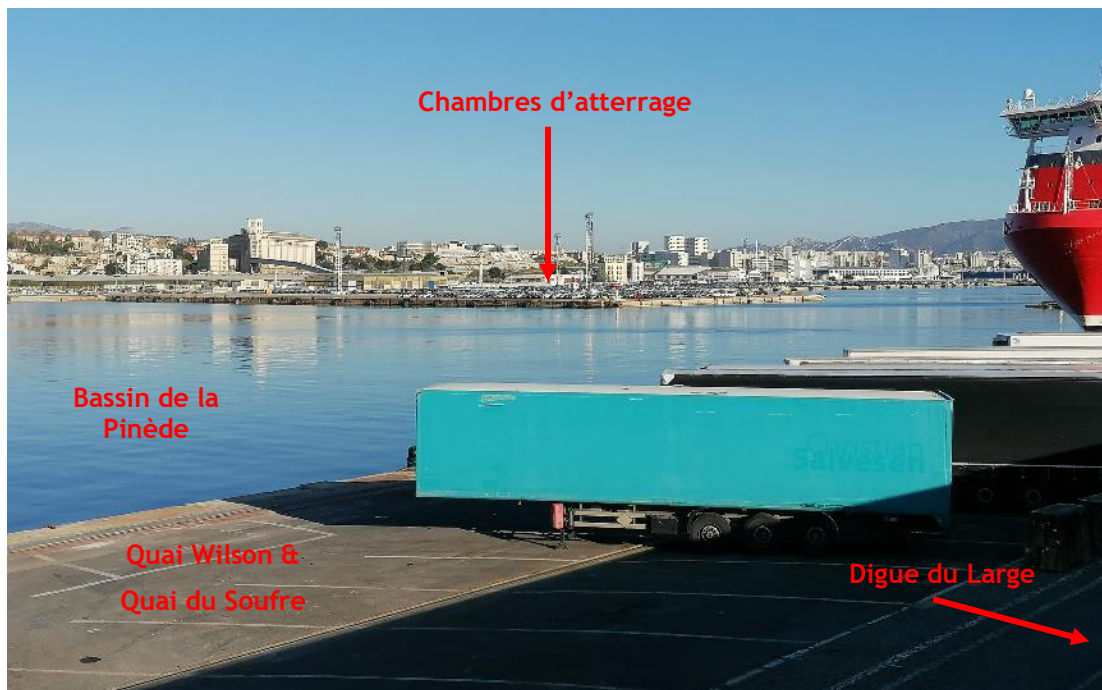
Figure 6 : Vue de l'emplacement des chambres d'atterrage des câbles M2 et M3 par-delà le bassin de la Pinède depuis la Digue du Large (mars 2020)
