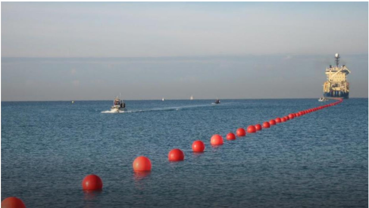
Figure 16 : Tirage du câble du navire câblé vers la côte (Source : ASN)
