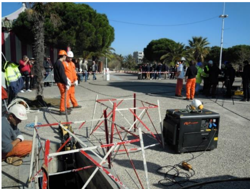
Figure 18 : Tirage du câble en dehors de la chambre plage avant raccordement (photo : setec in vivo)
