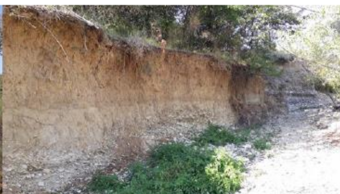
Les berges argilo-sableuses posées sur des galets sont abruptes
