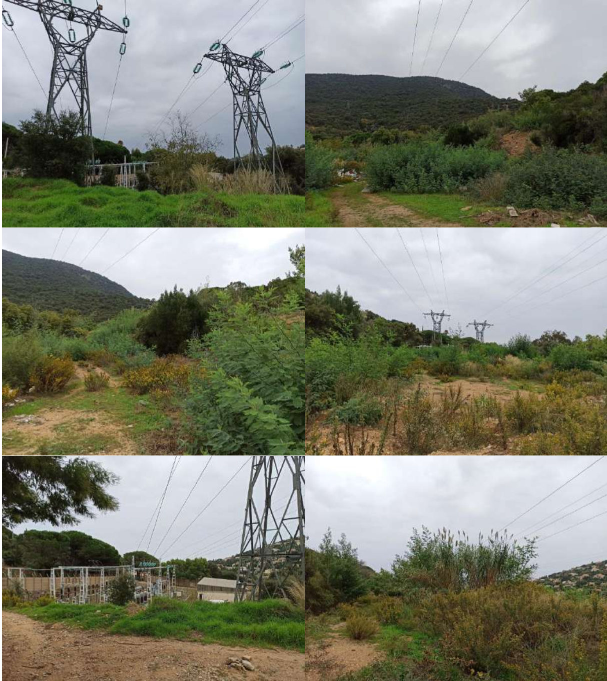
Photo 11 : Lignes à haute tension (pylônes et lignes) présentes dans l'ouest du secteur d'étude
