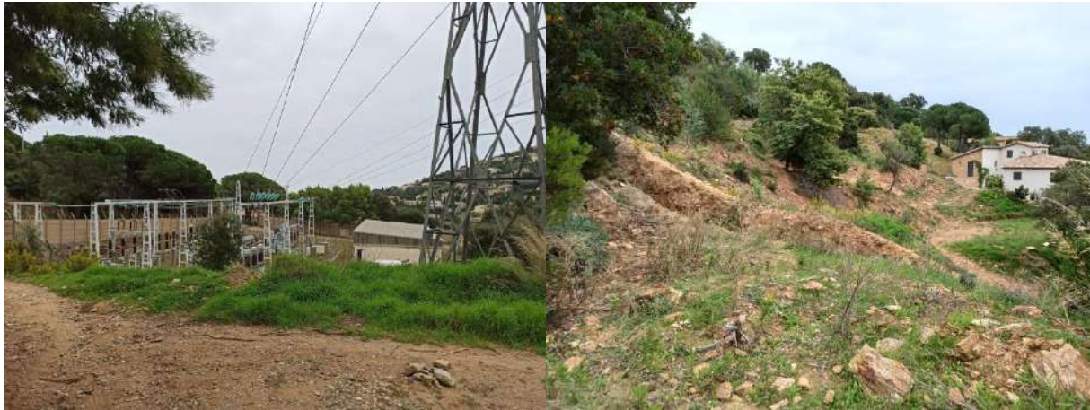
Photo 5 : Poste électrique avec lignes à haute tension au sud du secteur d'étude et vue sur une villa résidentielle à l'est du secteur d'étude (EVEN, Novembre 2020)
