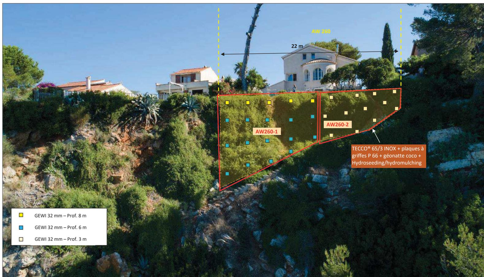
Figure 49 : Falaise sous la parcelle AW 260 – vue en élévation des confortements
