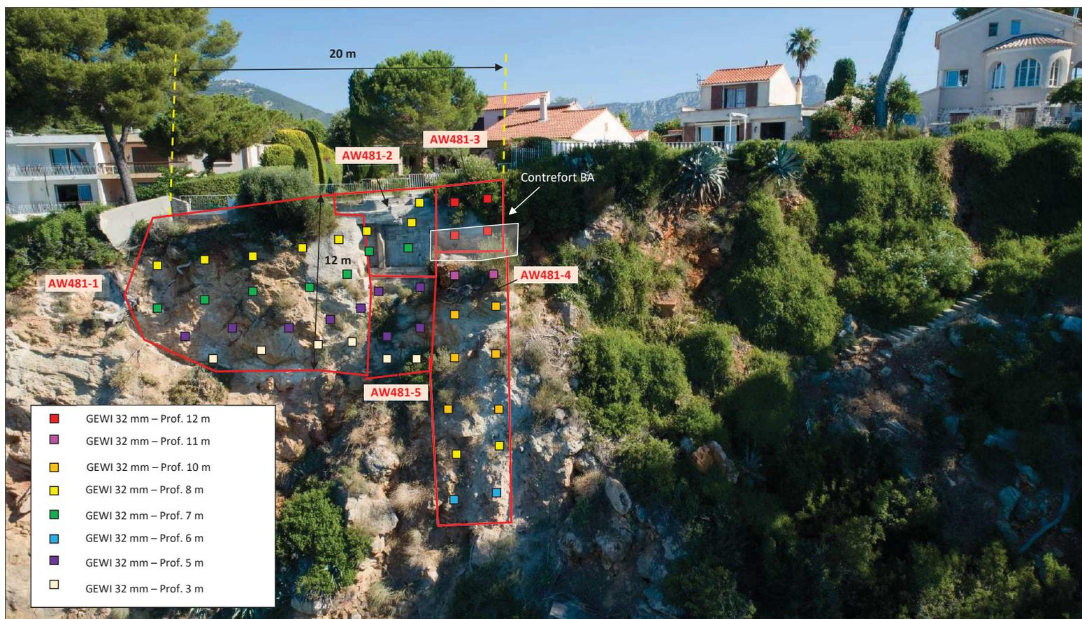
Figure 47 : Falaise sous la parcelle AW 481 – vue en élévation des confortements
