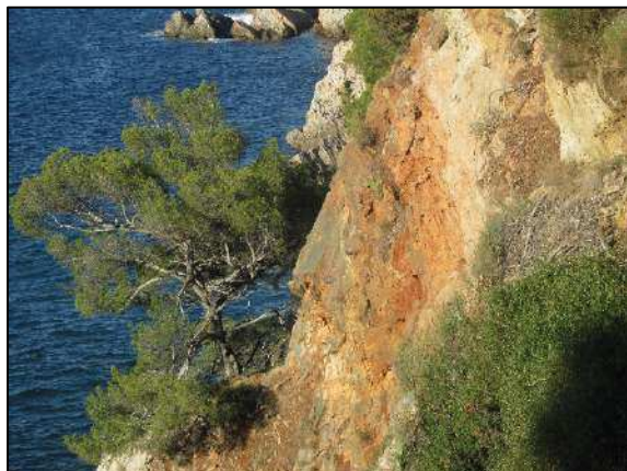
Aperçus de la zone d'étude, falaise au nord-ouest
