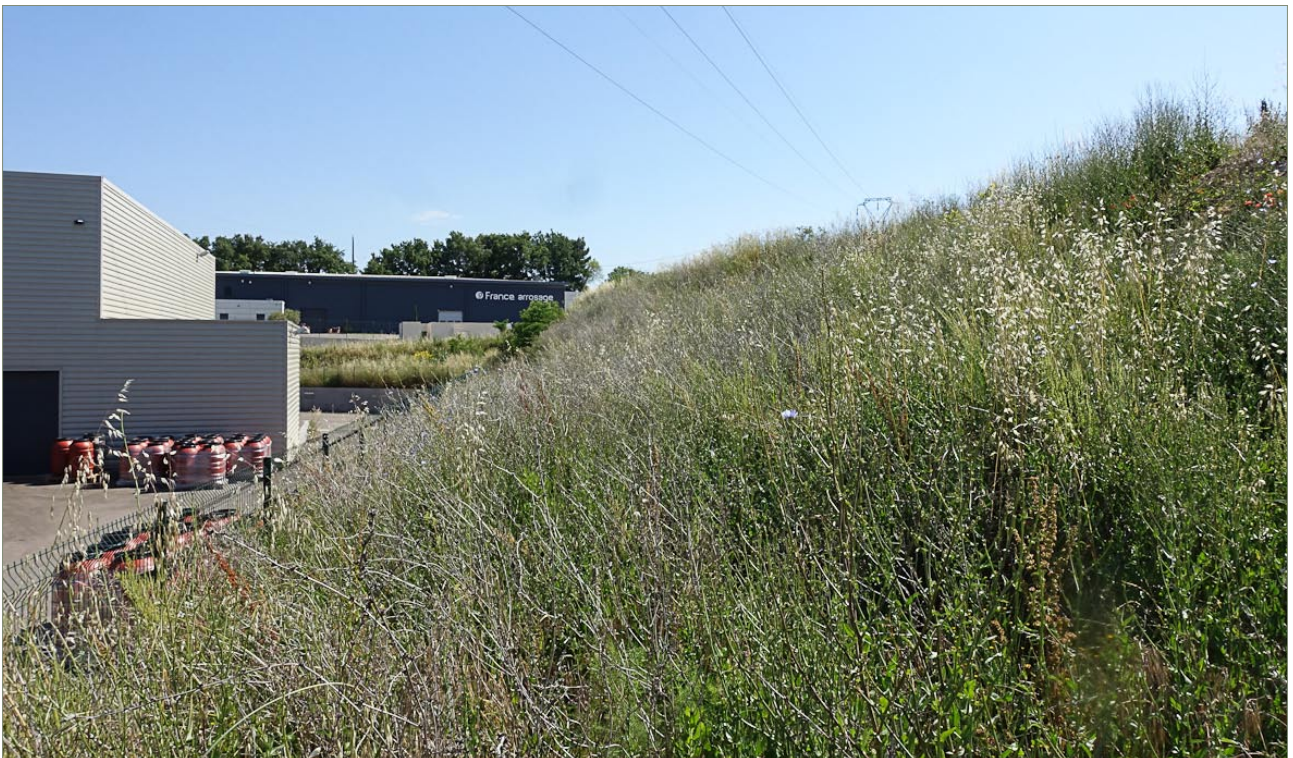
Talus enherbé Ouest du site, permettant d'apprécier la hauteur du remblai.
