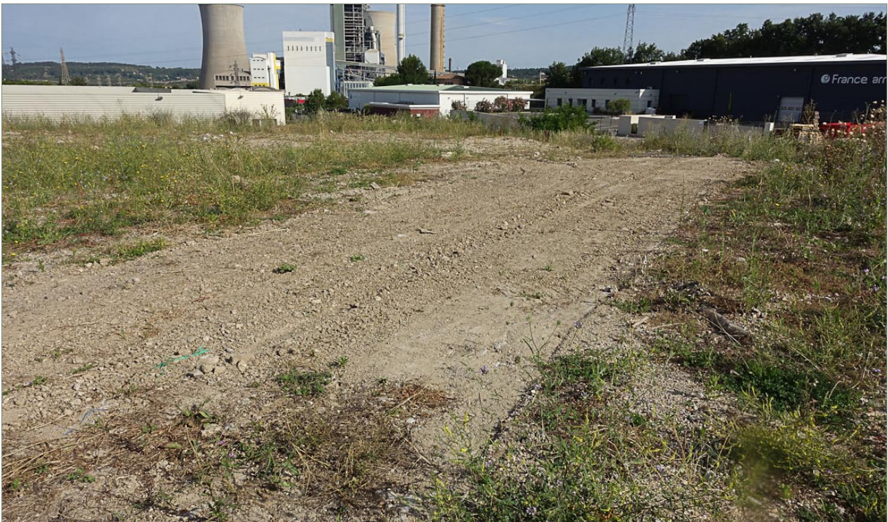
Des travaux de terrassement ont encore été réalisés courant juin 2020.
