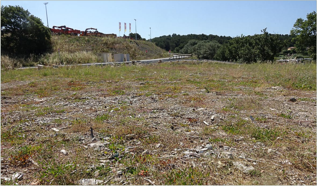
Plate-forme de remblai et vue sur l'aménagement au Nord-Est.
