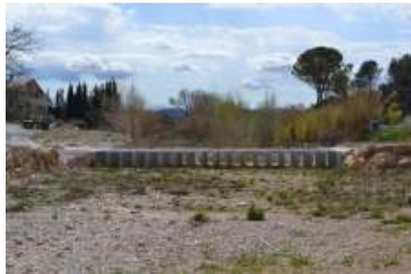
Aménagement d'un pont submersible
