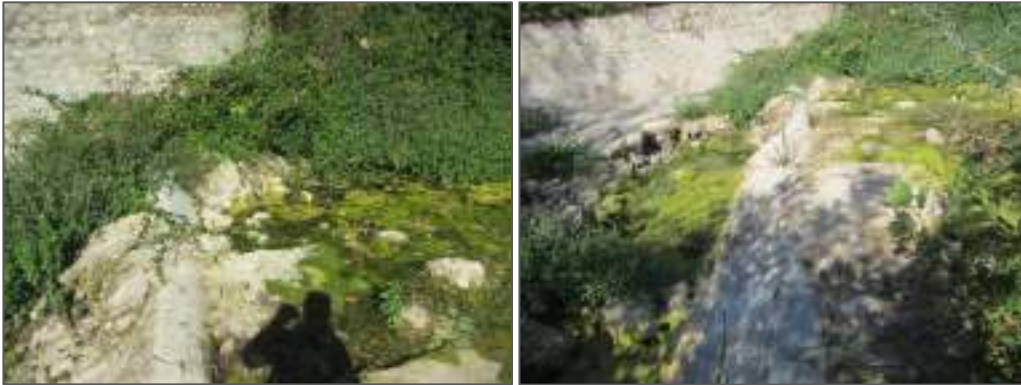
Eutrophisation en entrée de traversée de Taradeau
