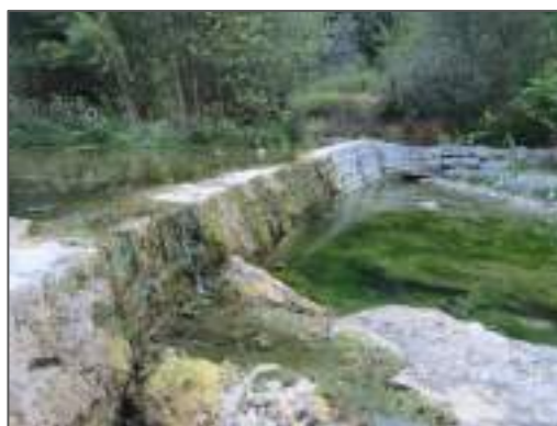
Vue sur le seuil du Moulin
