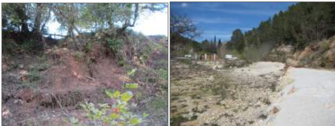
Erosion des berges due à l'absence de végétation rivulaire
