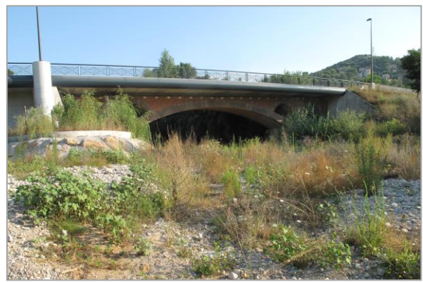
Pont de la RD 10
