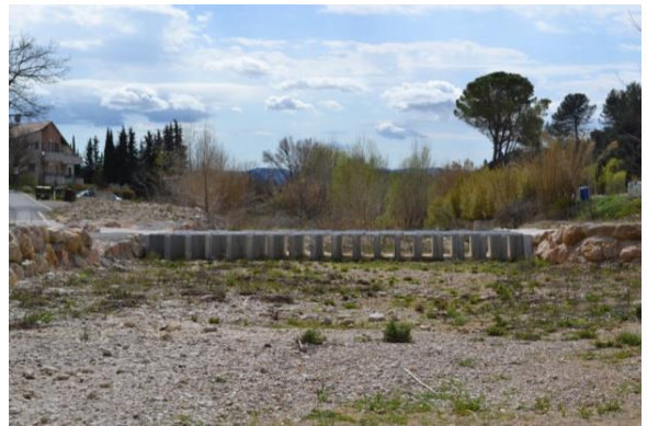
Aménagement d'un pont submersible
