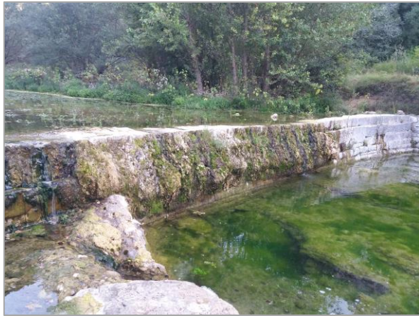
Seuil du moulin
