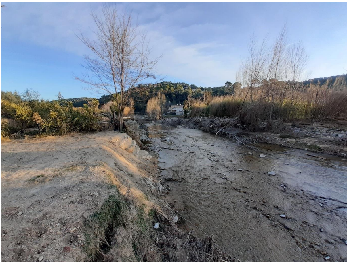
Figure 21 : Photo post crue Novembre 2019
