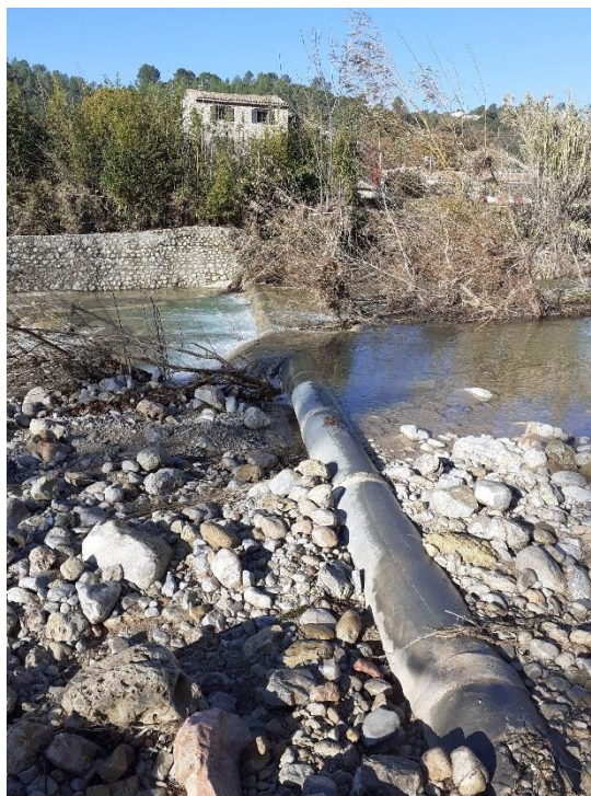
Figure 11 : Visualisation de la conduite siphonnante à supprimer
