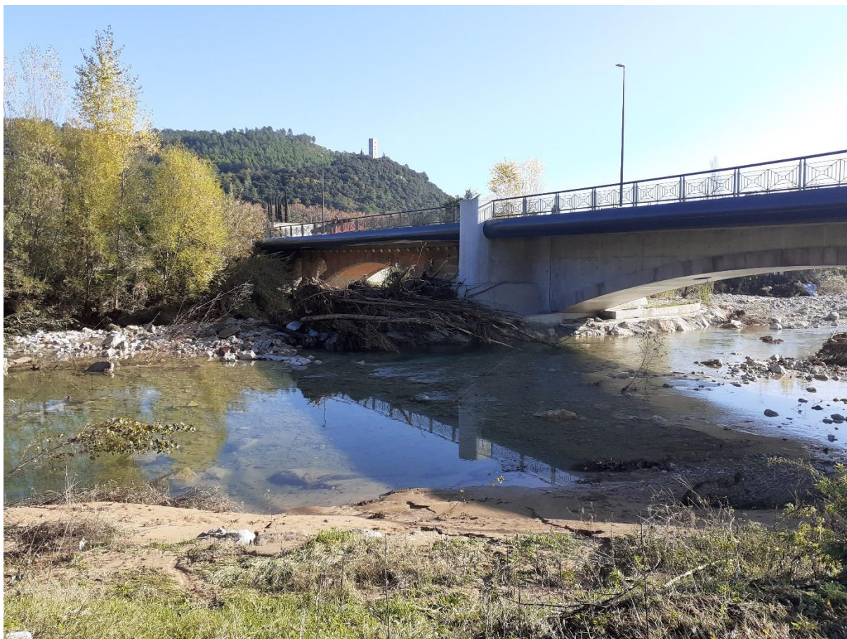
Figure 22 : Exemple d'embâcles amoncelés sur la pile du pont et pouvant être gruté depuis la route.
