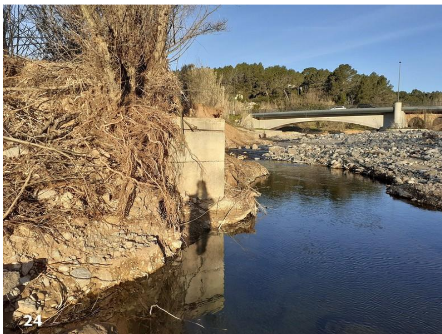
Figure 17 : Regard d'eau usée en rive droite aval du pont mis à nu après la crue de Novembre 2019
