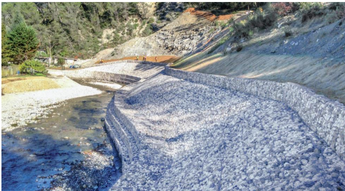
Figure 8 : Exemple d'ouvrage hydraulique en gabion créé pour la sécurisation du bassin versant instable des bouisses en contexte torrentiel
