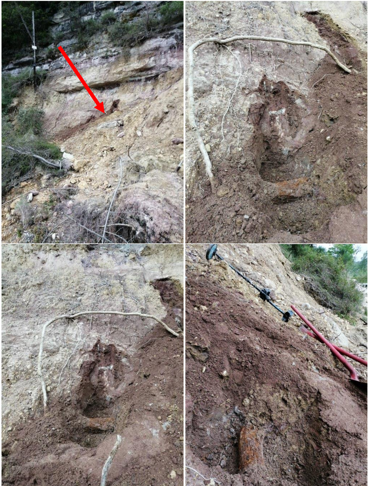
Figure 14 : Localisation de la conduite d'alimentation d'eau potable de Gayepan
