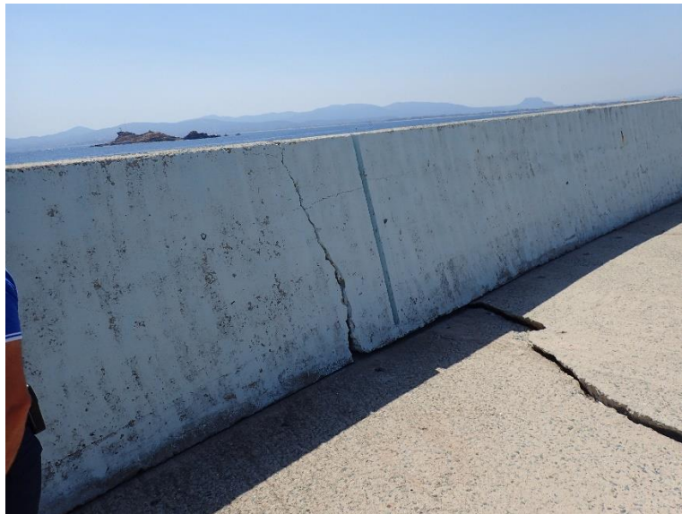
Photo n°2 – Fissuere sur la digue de protection promenade Sud Ouest - ICTP juillet 2019
