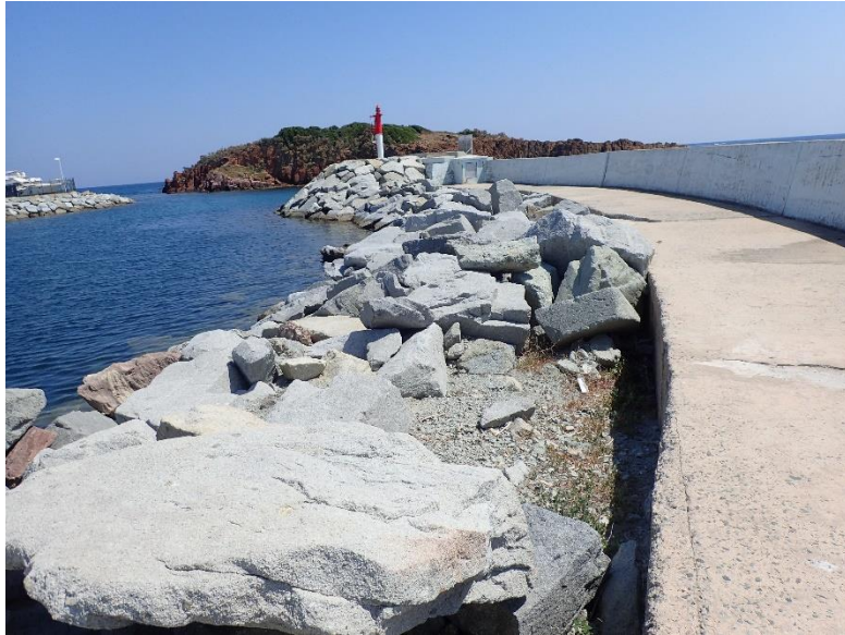
Photo n°1 – Digue de protection promenade Sud Ouest- ICTP juillet 2019
