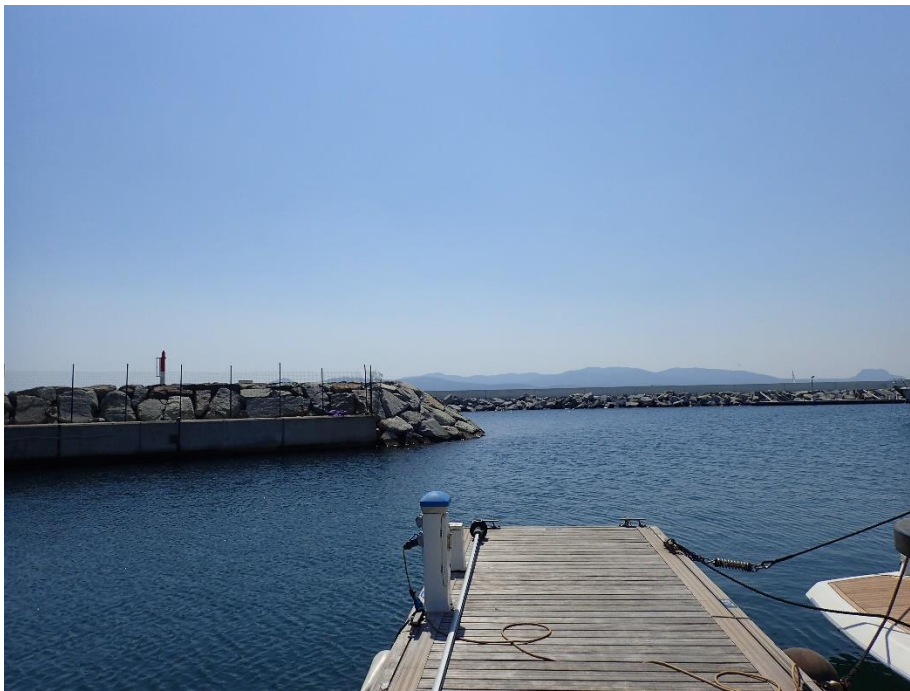
Photo n°4 – Vue depuis le ponton n°10- ICTP juillet 2019
