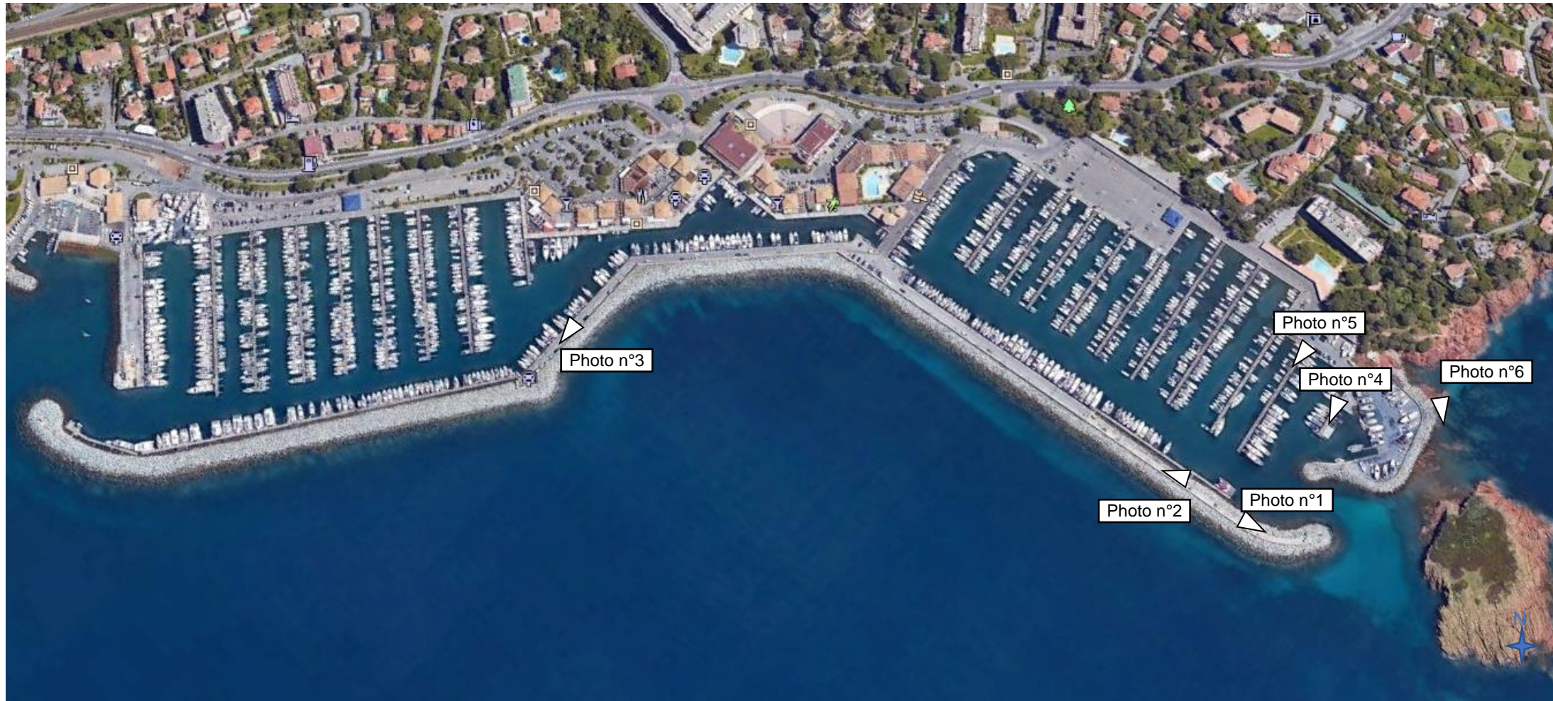
Figure 4 : Avant-port de Théoule - Localisation des prises de vue – Google Earth
