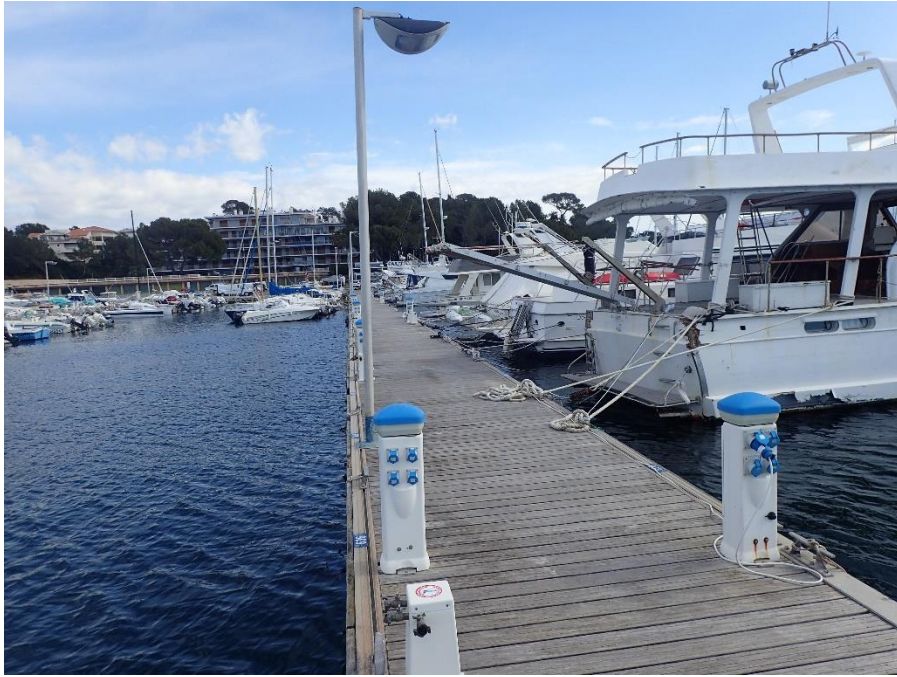
Photo n°5 – Vue depuis le ponton n° 9 - ICTP juillet 2019
