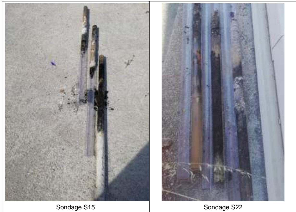
Figure 18 : Reportage photographique des sondages réalisés
