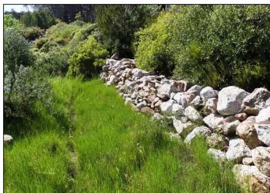
Exemple de muret en pierre sèche ECO-MED
