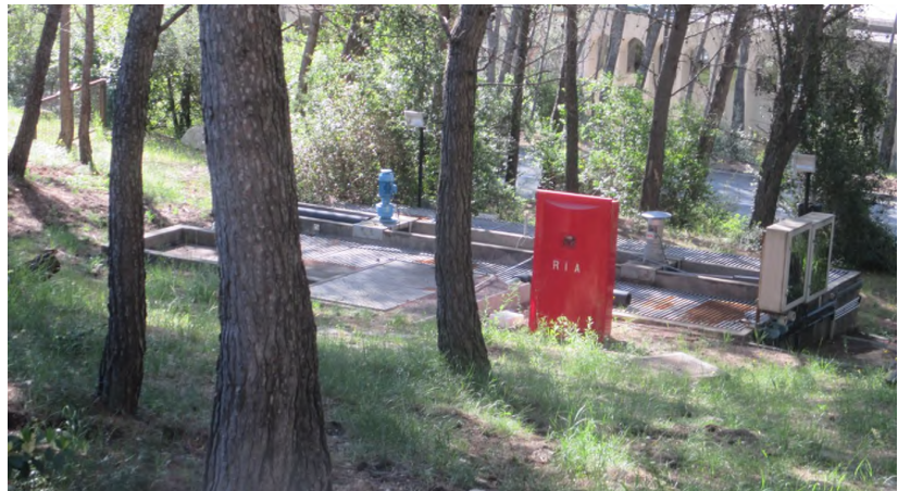
Photographie prise le 19/05/2019 de la zone des réservoirs des eaux usées
