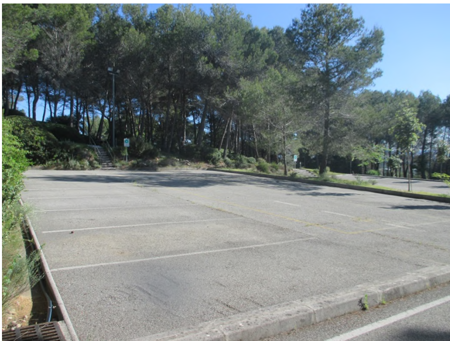
Vue sur la partie haute du parking (ouest du site)
