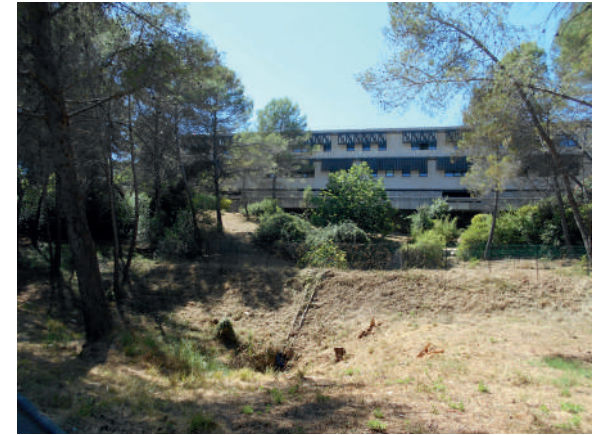
V15 - Vue bloquée par le bâtiment existant
