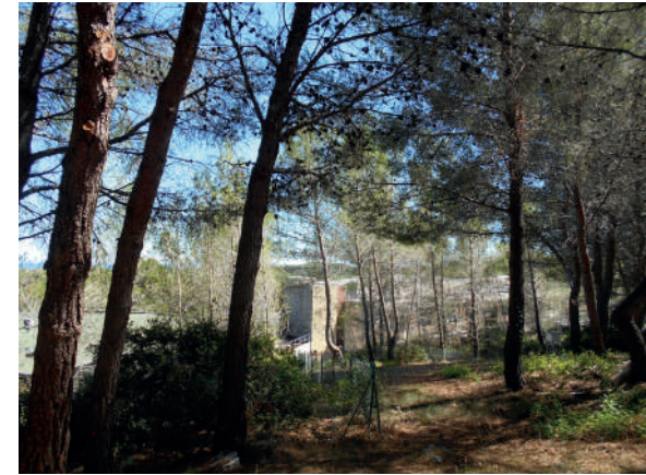
V3 - Vue partielle du bâtiment existant au travers de la pinède
