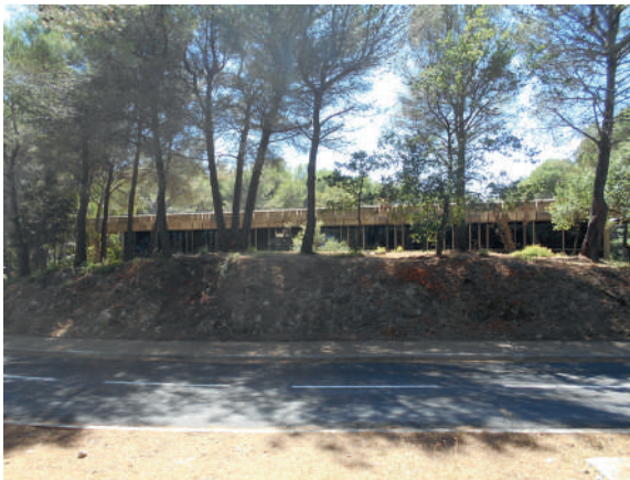
V4 - Vue vers l'extérieur du site bloquée par le bâtiment voisin
