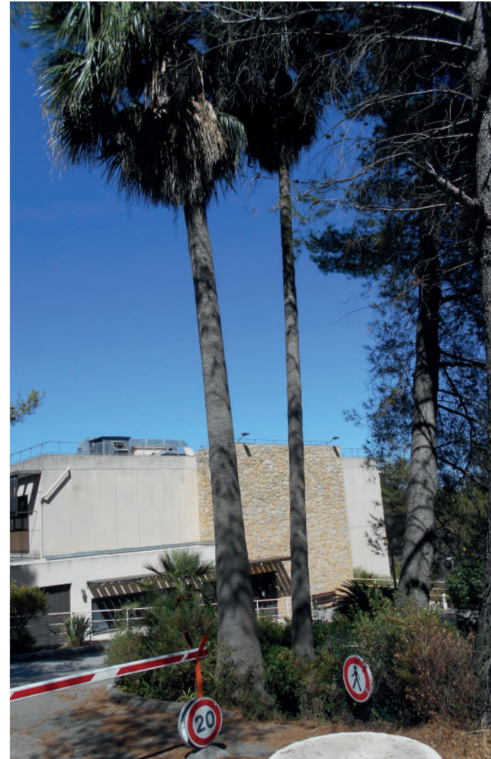
La végétation exotique autour du bâtiment
