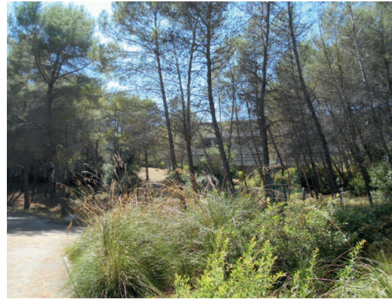
V14 - Vue partielle du bâtiment existant au travers de la pinède
