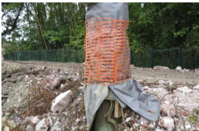
Exemples de protection d'arbres à leur base pour éviter des blessures par les engins de chantier - ECOTER 2013
