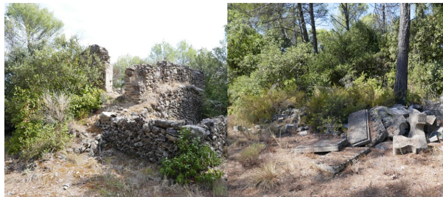
Figure 3 : ruine et dépôt de matériaux
