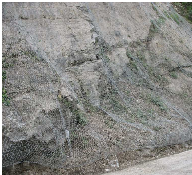
Exemple de filet pendu PR 86+730
