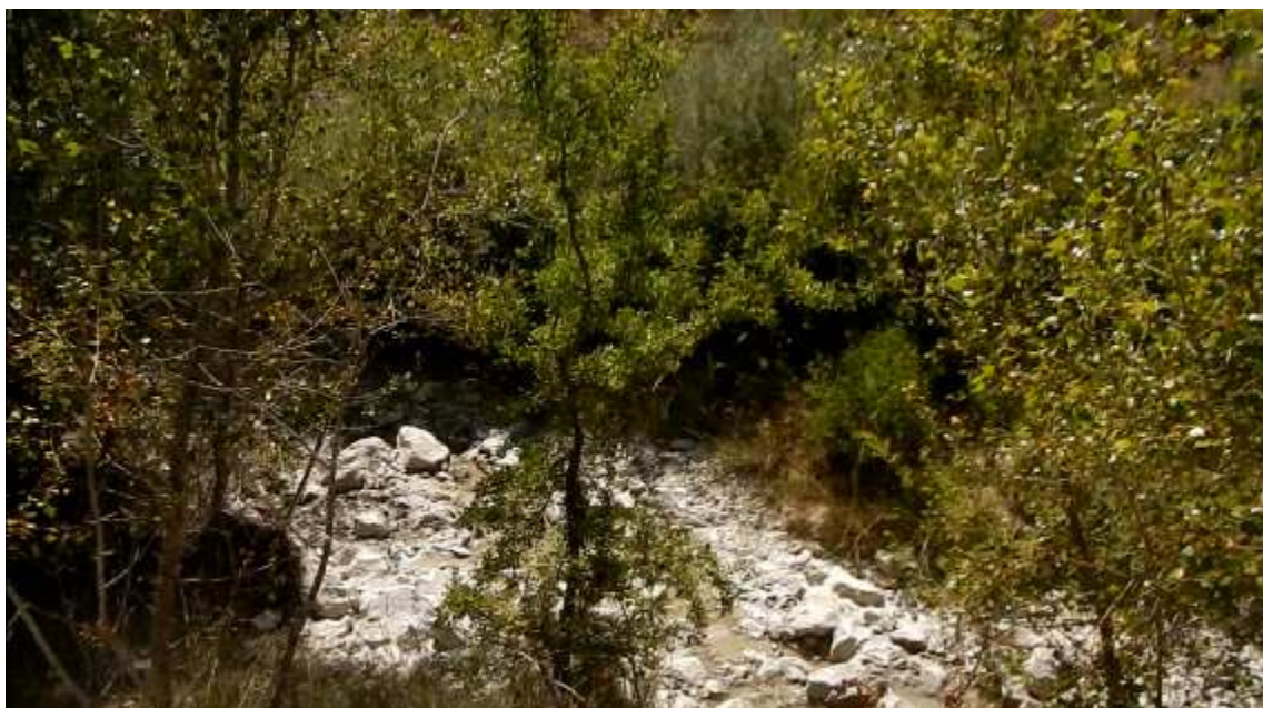
Photo 5 : cours d'eau au pont du Lieu-dit Les Rouines
