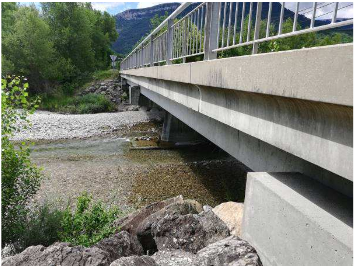
Photo 8 : traversée en encorbellement du Jabron au niveau du pont
