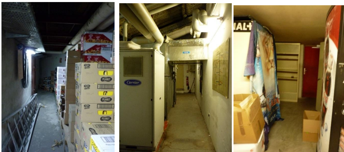
Figure 14 : Sous-sol et combles du cinéma actuel non connecté à l'extérieur
