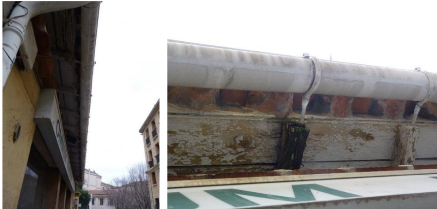
Figure 6 : Avancés de toit de la façade Sud de l'ancienne agence de voyage propices à la nidification des passereaux
