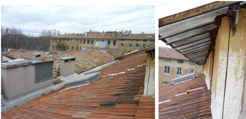
Figure 7 : Avancés de toit de la verrière du Passage propices à la nidification des passereaux
