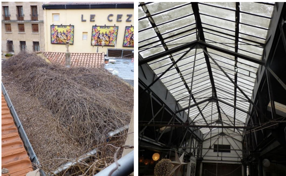
Figure 10 : Cheminée, pergola et verrière de l'ancien restaurant lumineuses
