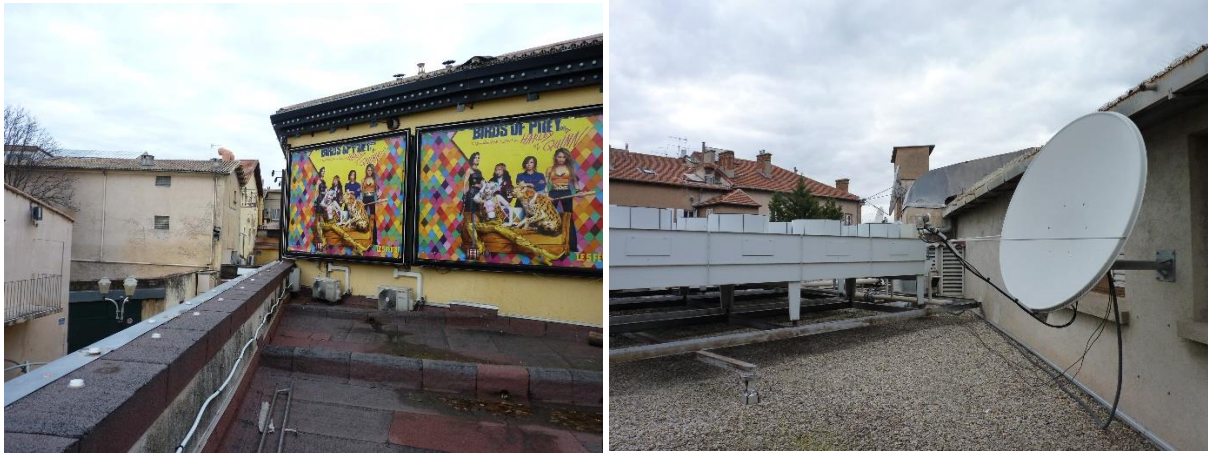
Figure 15 : Pas d'accès aux charpentes depuis les toits du cinéma actuel
