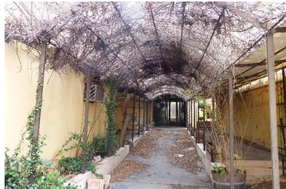
Figure 8 : Entrée de l'ancien restaurant, EODD
