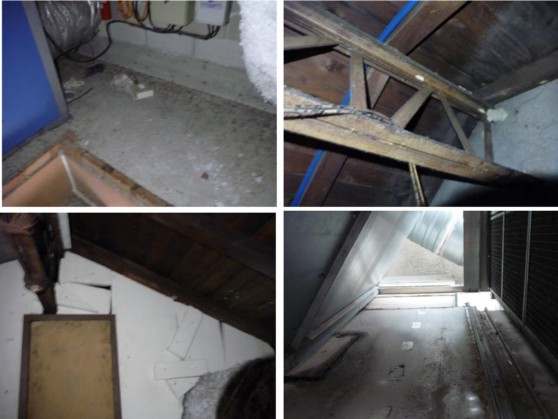
Figure 9 : Comble de l'ancien restaurant ouverte sur l'extérieur
