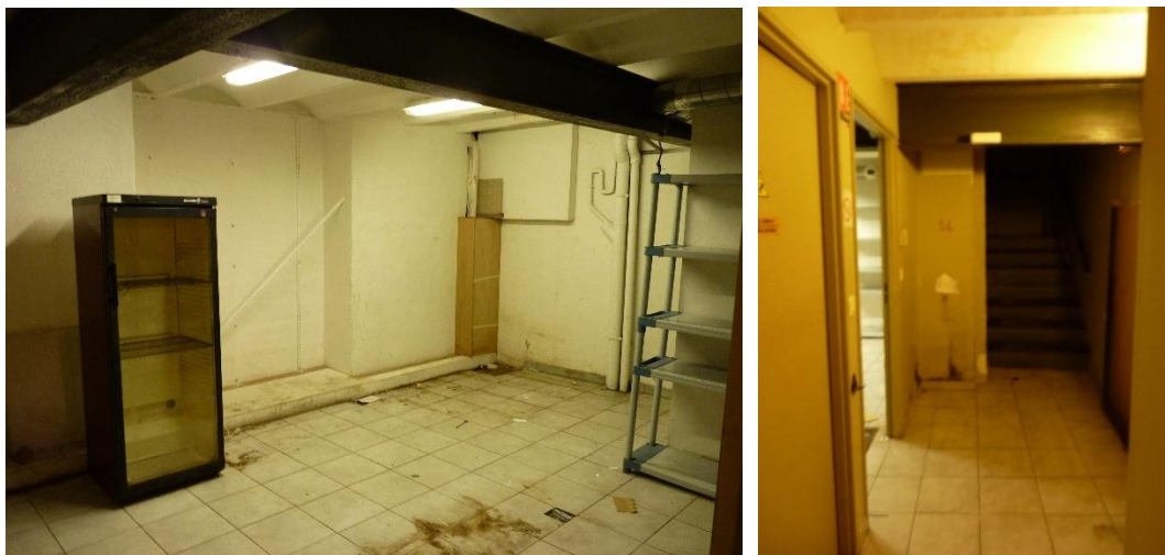
Figure 11 : Sous-sol de l'ancien restaurant non connecté à l'extérieur
