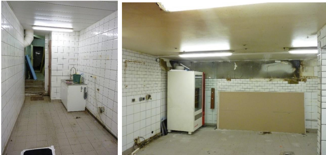
Figure 12 : Locaux de l'ancienne agence de voyage non connecté à l'extérieur
