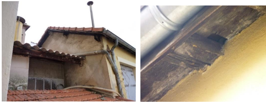
Figure 5 : Avancés de toit de la façade Nord et Est du cinéma « Le Mazarin » propices à la nidification des passereaux
