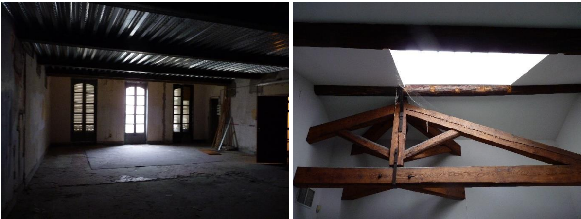
Figure 13 : Locaux de l'immeuble rue Mazarine non connecté à l'extérieur et trop lumineux
