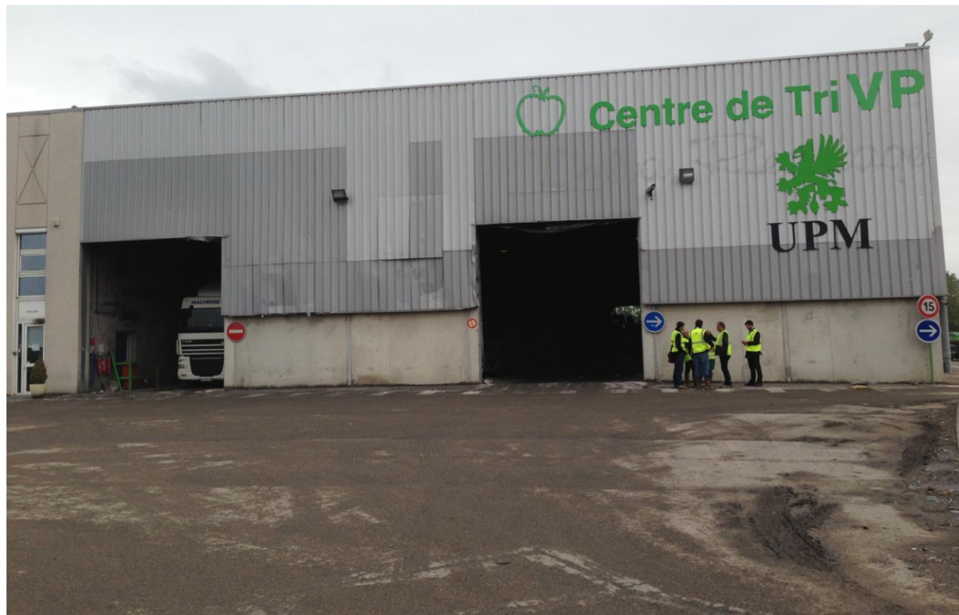
Secteur d'étude avant incendie
