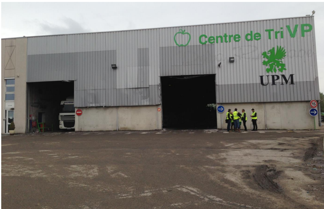
Secteur d'étude avant incendie
