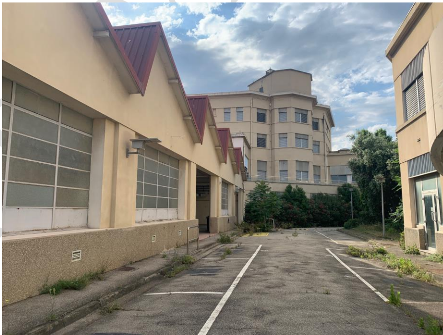
Figure 3 : vue du bâtiment existant
