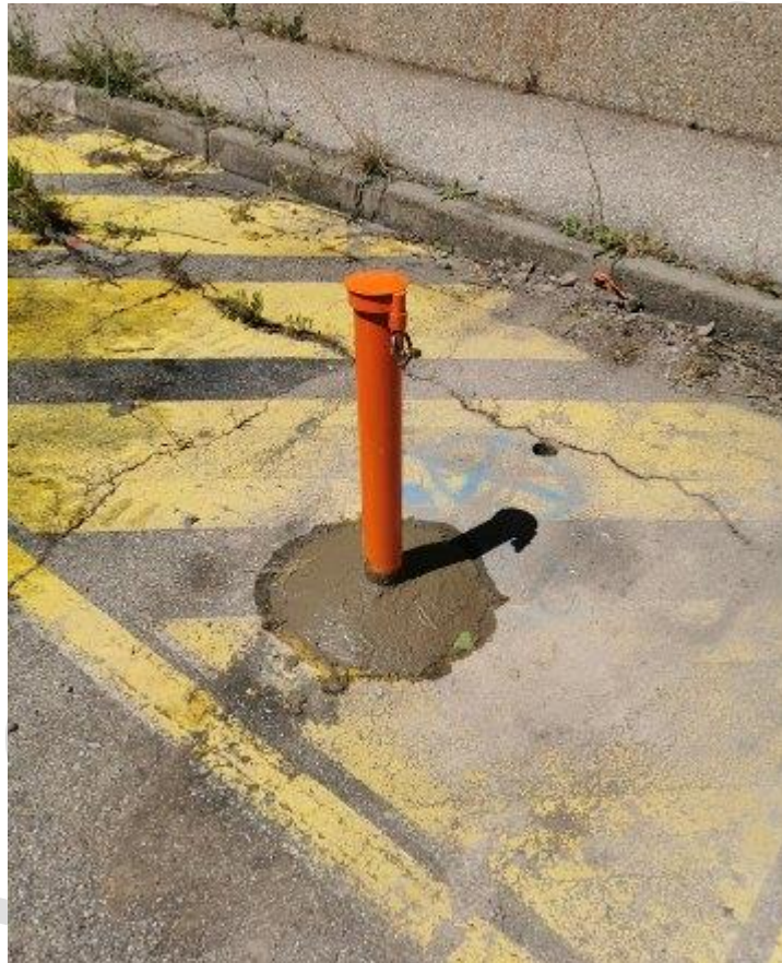
Figure 5 : photographie du piézomètre mis en place
