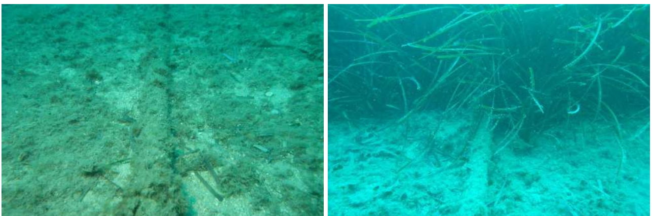
Figure 21 : Câble entièrement colonisé et pénétrant dans un îlot d'herbier sans impact apparent
