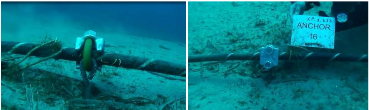
Figure 34 : Autre système de fixation du câble à l'ancrage retenu pour le projet (Orange Marine)
