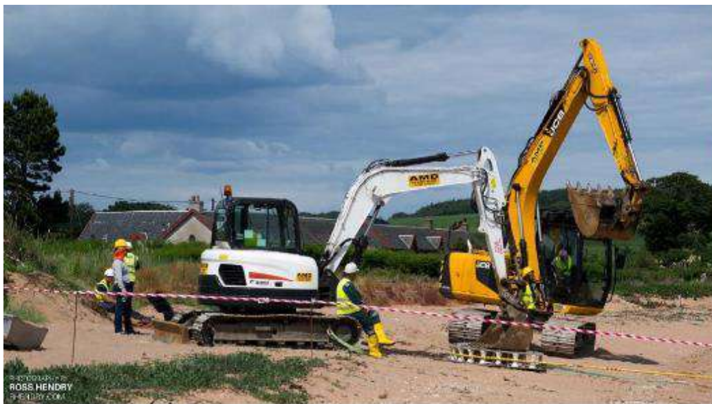
Figure 24 : Opération de tirage de câble avec deux pelleteuses et un quadrant (Orange Marine)
