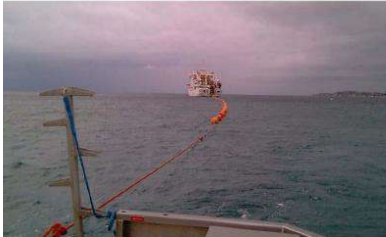
Figure 23 : Exemple de tirage d'un câble depuis un navire câblé vers la plage (Orange Marine)
