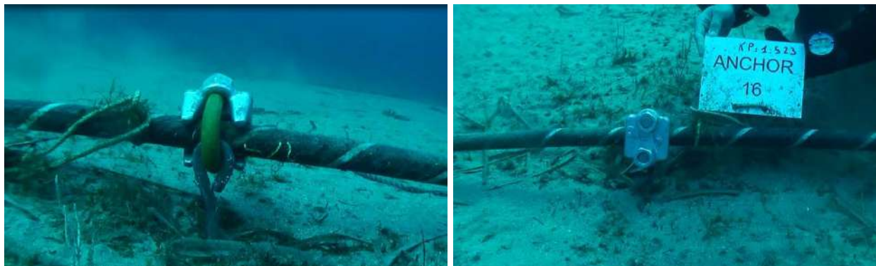
Figure 18 : Autre système de fixation du câble à l'ancre retenu pour le projet (Orange Marine)
