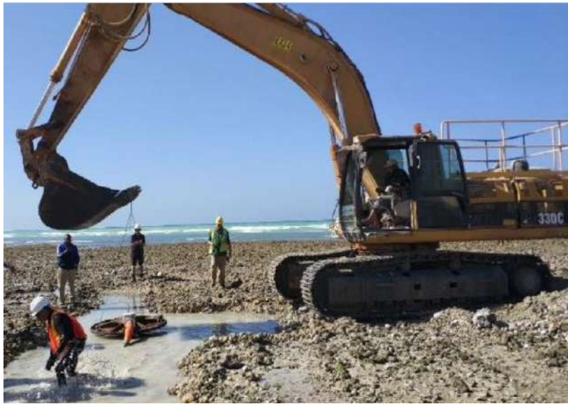
Figure 17 : Photo de travaux d'excavation préparant l'installation de la « sea plate » (source : HMN)
