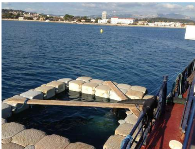
Figure 85 : Barrage anti-MES déployé pour contenir les rejets d'aspiration des sédiments de la tranchée d'ensouillage du câble MEUST (photo : AZCO ROV)
