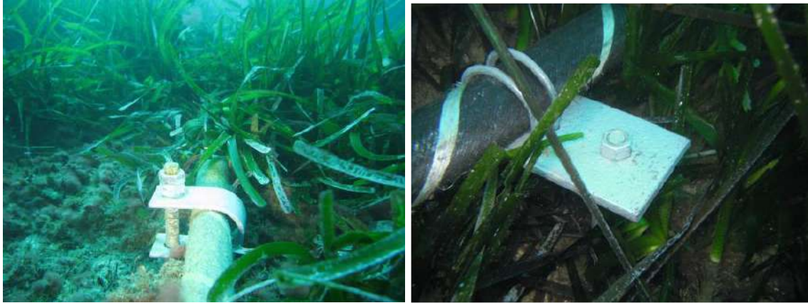
Figure 33 : Deux systèmes de fixation d'ancres à vis installées en zone d'herbier (photo : setec in vivo)
