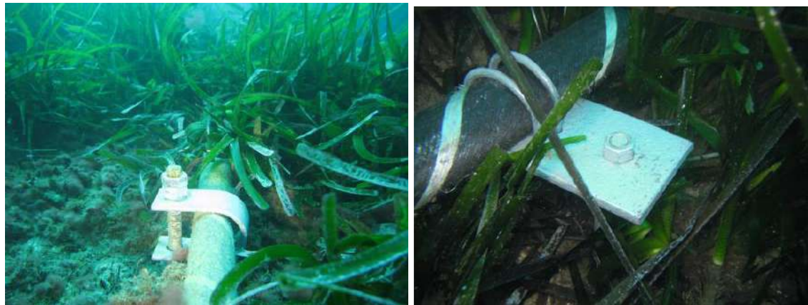
Figure 17 : Deux systèmes de fixation d'ancres à vis installées en zone d'herbier (photo : setec in vivo)
