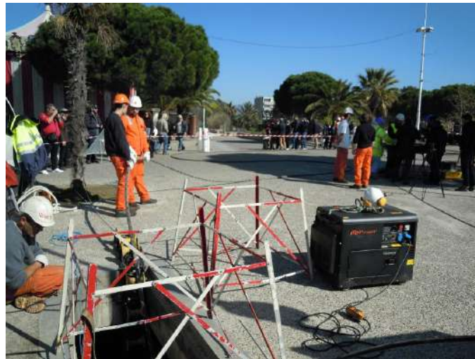
Figure 10 : Tirage du câble en dehors de la chambre plage avant raccordement (photo : setec in vivo)
