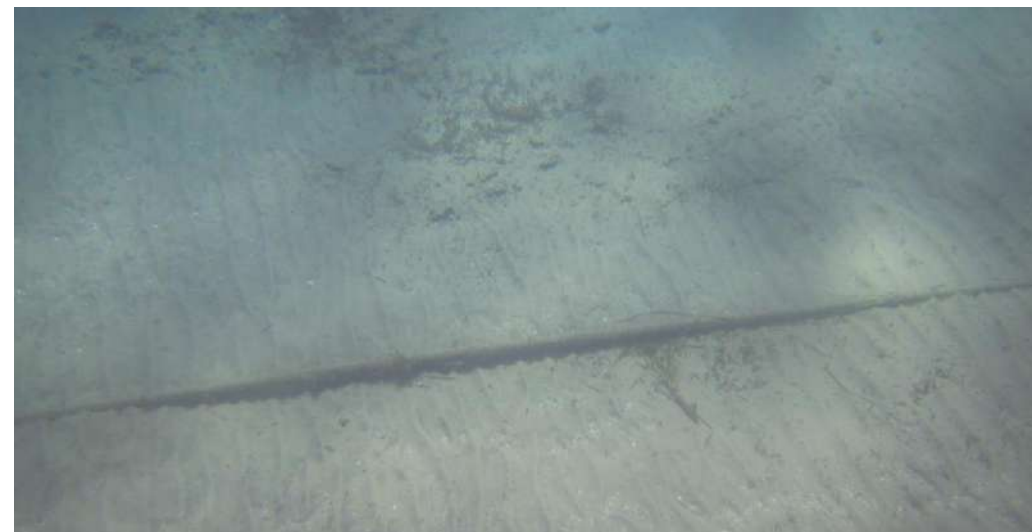
Câble double armure DA posé
