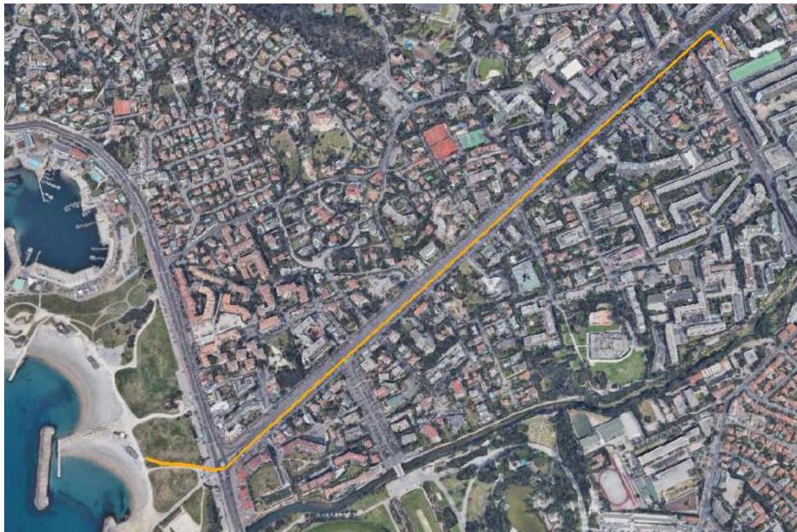
Figure 3 : Site d'implantation du câble PEACE MED entre la chambre-plage sur le Prado et la station terminale
