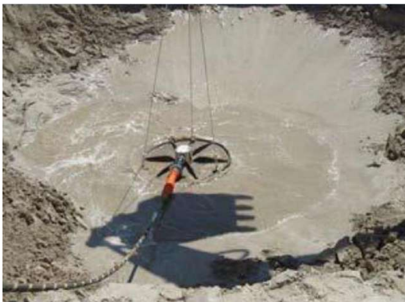
Figure 18 : Photo de la « sea plate » installée sur une plage, raccordée à la chambre-plage (source : HMN)
