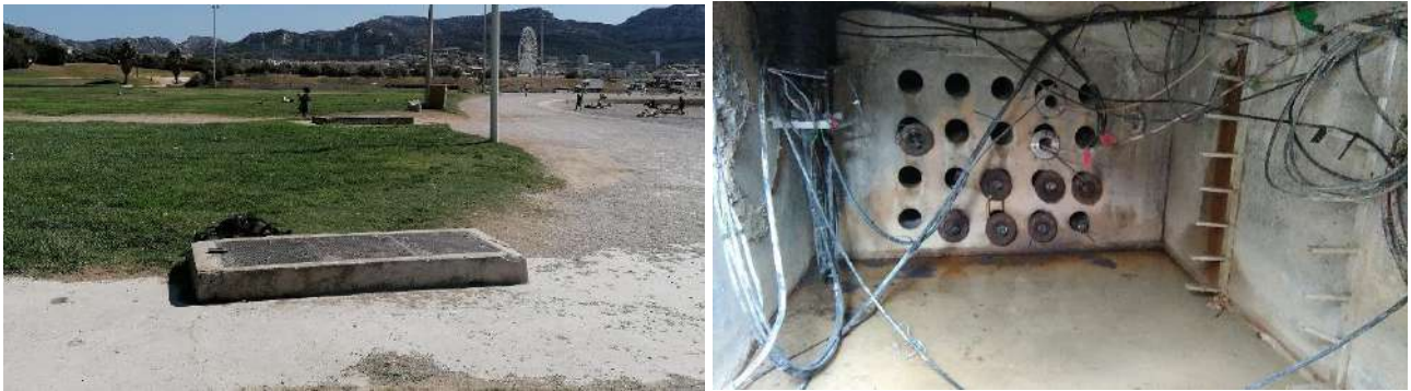
Figure 22 : Photos extérieures et intérieures de la chambre plage existante (source : Orange)
