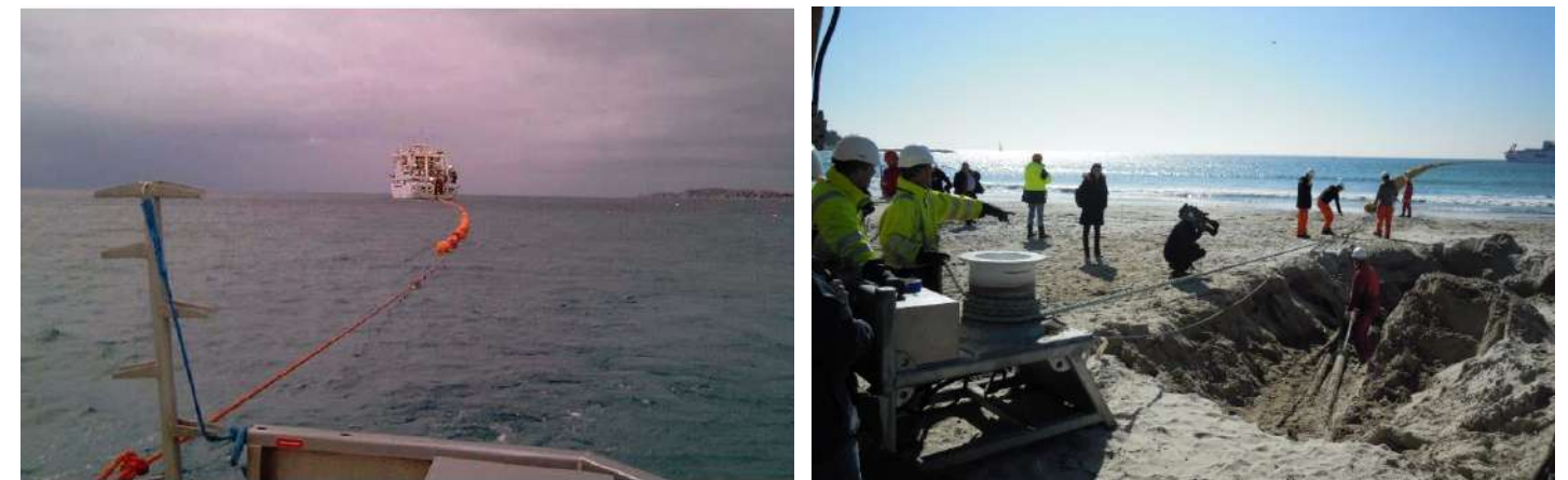
Figure 9 : Tirage du câble du navire câblé vers la plage (photos : à gauche, Orange Marine et à droite, setec in vivo)
