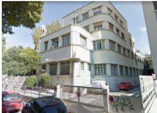
Figure 7 : La station terminale d'Orange située dans le quartier de Saint Giniez à Marseille (source : Orange)
