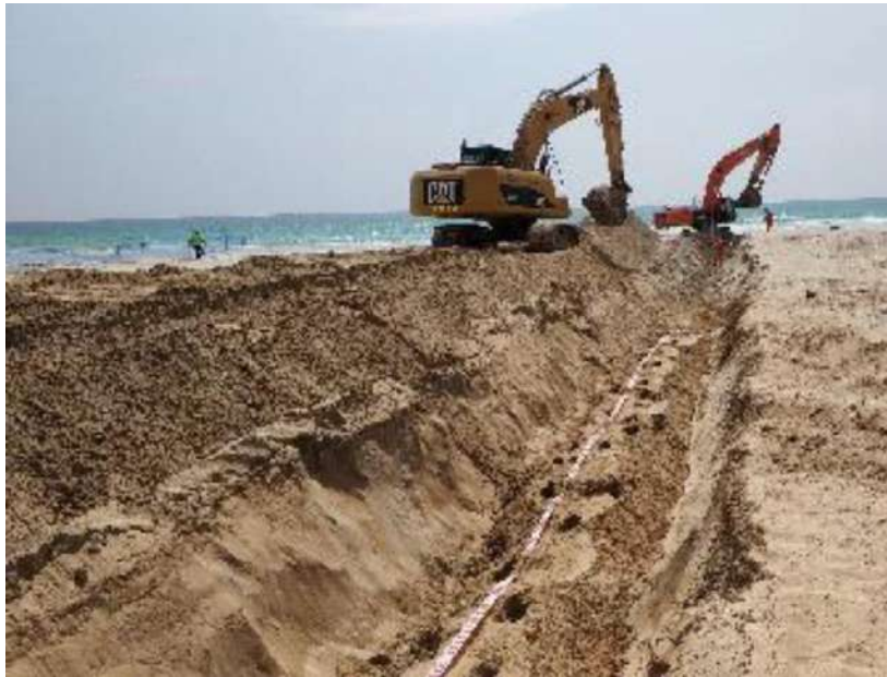
Figure 19 : Photo de la tranchée de raccordement de la « sea plate » à la chambre-plage (source : HMN)
