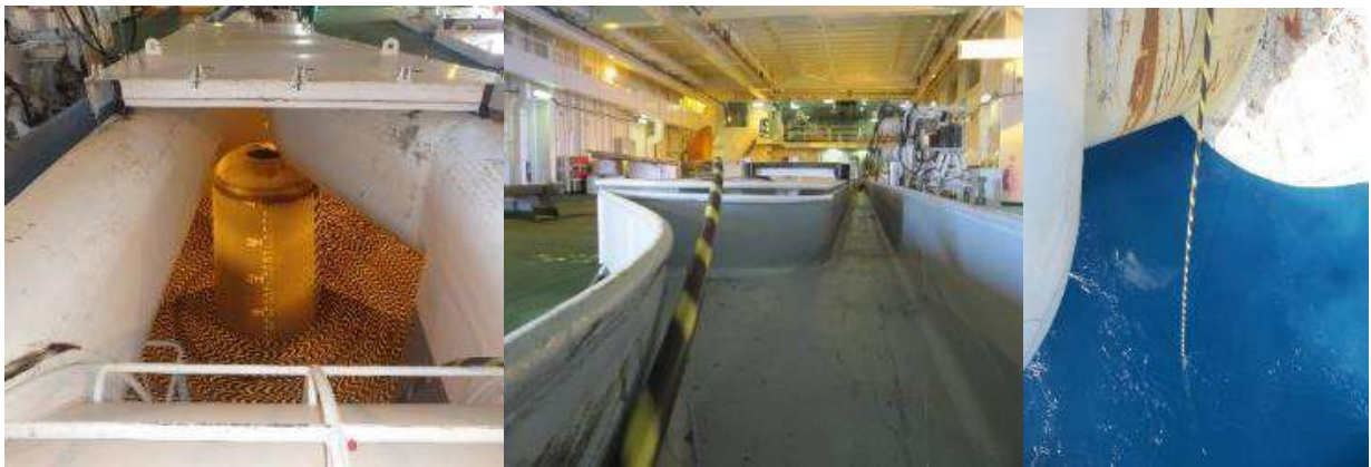
Figure 37 : Déploiement d'un câble depuis la cuve de stockage (photos : setec in vivo)
