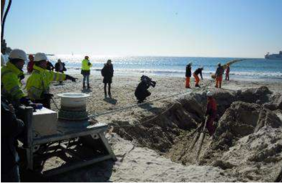
Figure 27: Opération de tirage du câble à terre avec un cabestan hydraulique (source : Orange marine)
