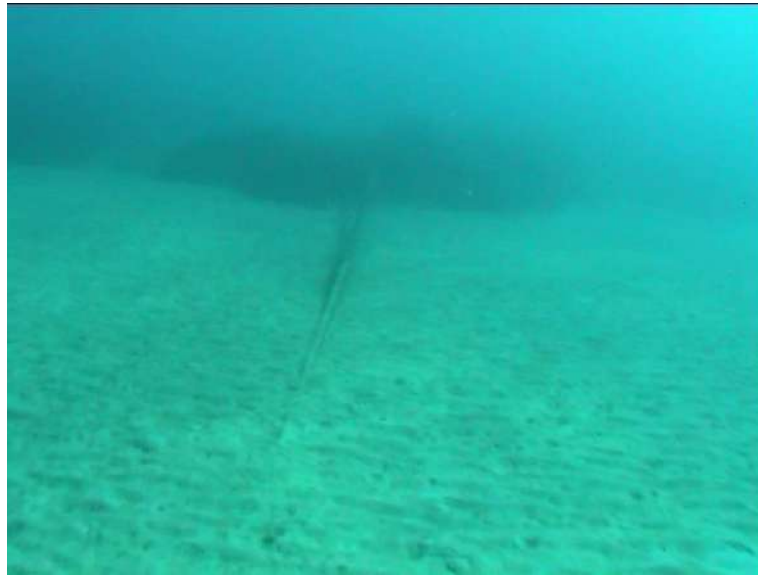
Figure 86 : Enfouissement naturel du câble dans les zones sableuses (setec in vivo, 2008)
