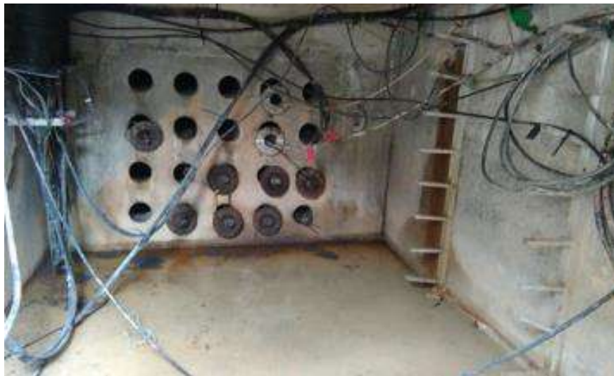
Figure 6 : Connectique et raccordement à l'intérieur de la chambre-plage (source : Orange)
