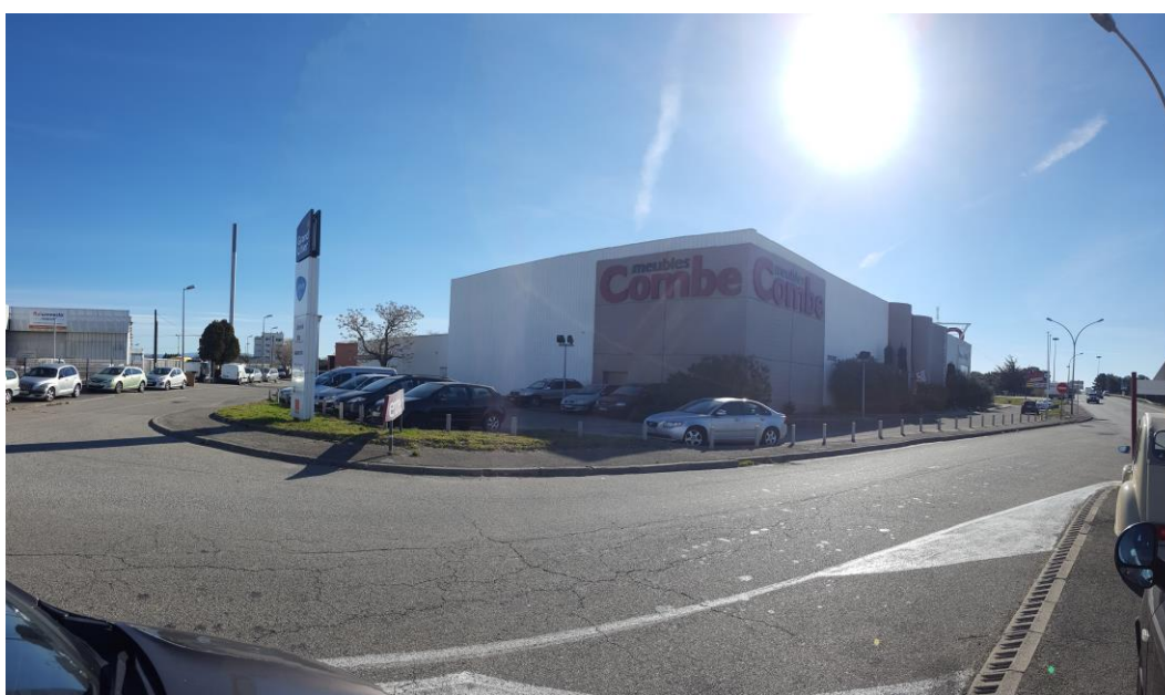
Illustration 7 : Photographie de la partie Nord-Ouest du projet depuis la RD907
